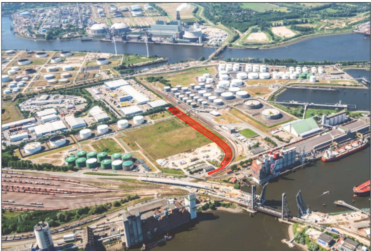
Abbildung 5: Ansicht Pumpenstation Westen / Süden
