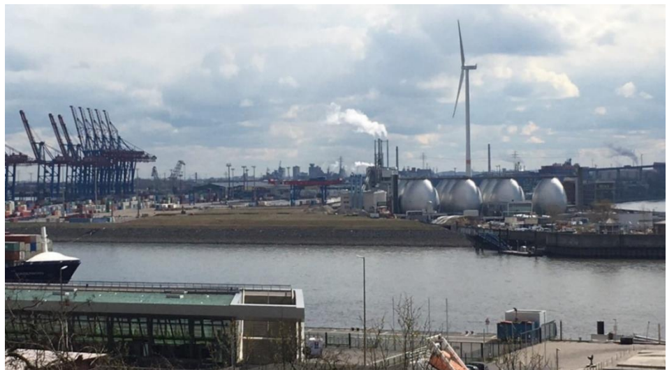
Abb. 10: Blick auf das Klärwerksgelände aus Richtung Altonaer Balkon
