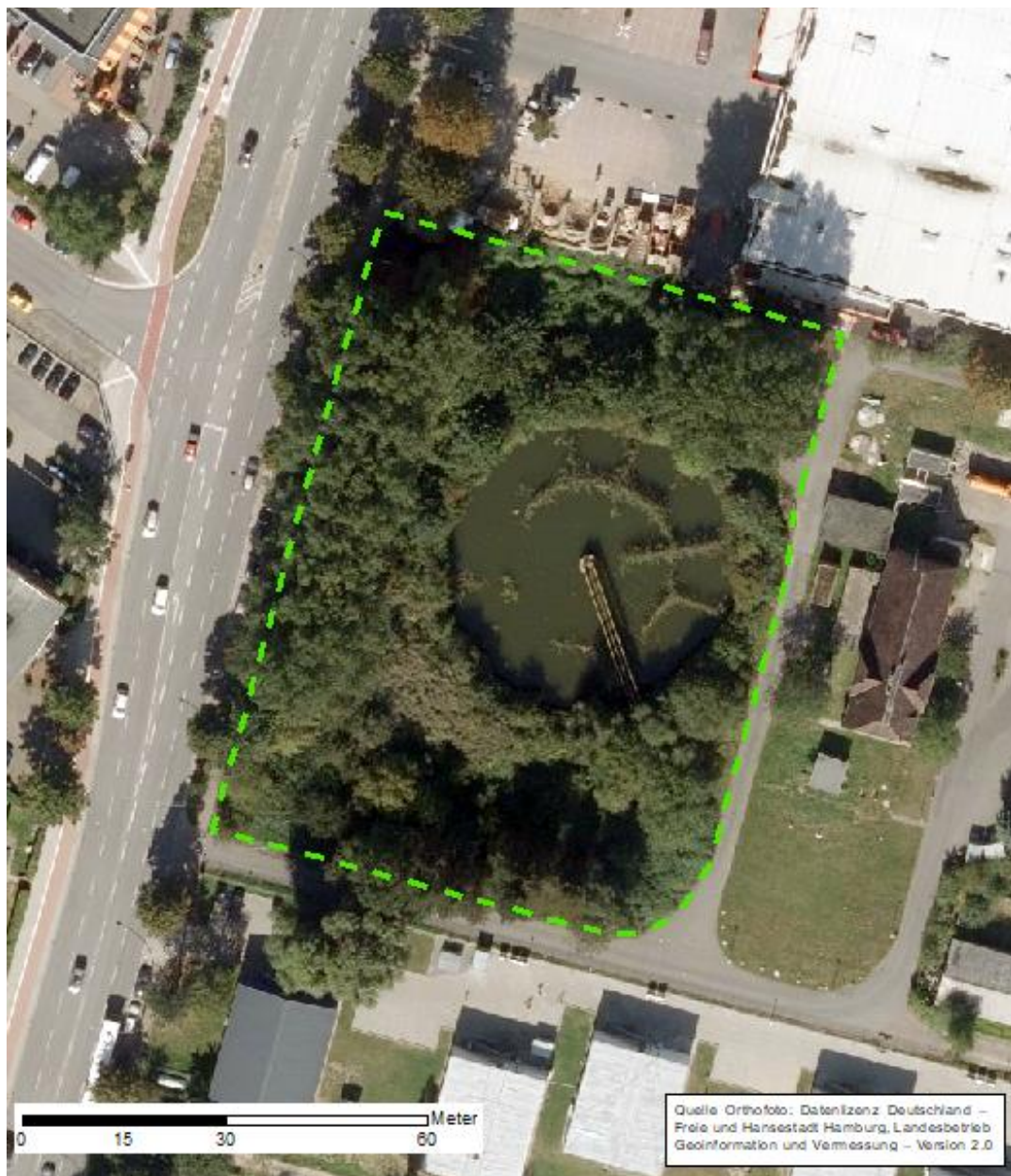
Abbildung 1: Blick auf das ehemalige Vorklärbecken und die angrenzenden Strukturen, Untersuchungsbereich (grün umrandet)
