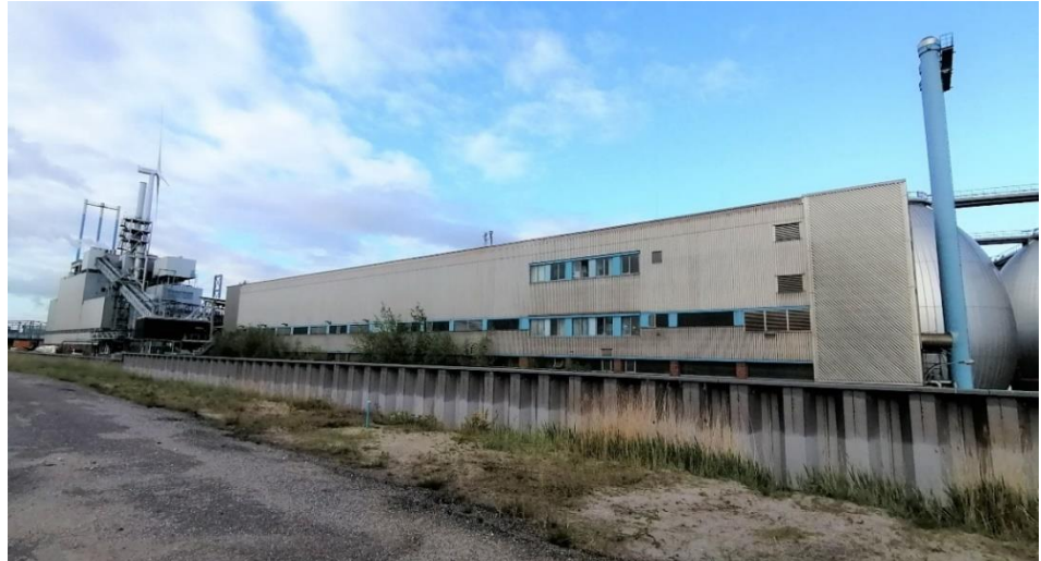
Abb. 9: Blick auf die Bestandsanlage der VERA und die KETA von Osten
