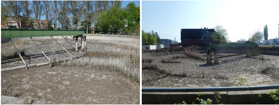
Abbildung 3: Blick auf das Vorklärbecken, links Richtung Westen, rechts Richtung Osten (Aufnahme Anfang 2020)
