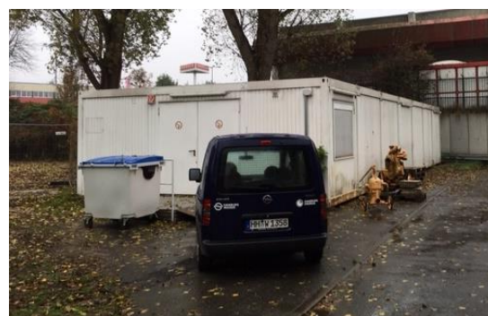
Abbildung 5: versiegelter Bereich mit Containern im Nordosten (Aufnahme 21/10/2019)
