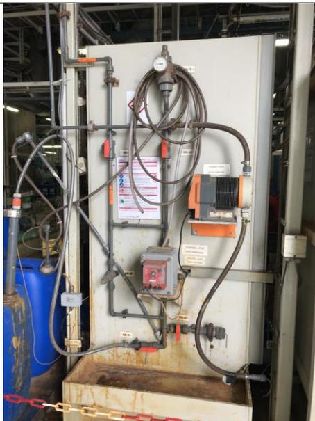
**Foto 3:** Dosierpumpe Eisen(III)Chlorid in
