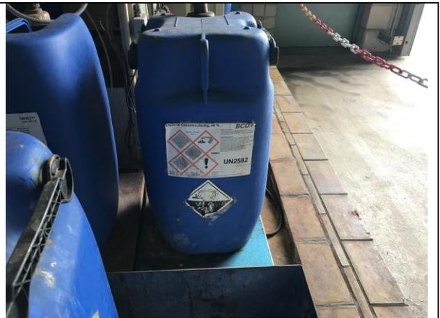
**Foto 2:** Eisen-III-Chlorid-Fass
