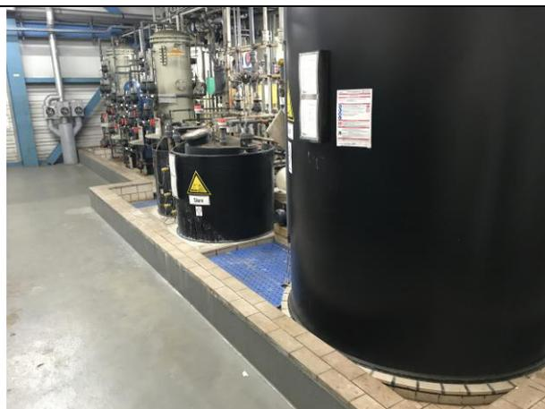
**Foto 9:** Salzsäure tanks (Wasseraufbereitung)
