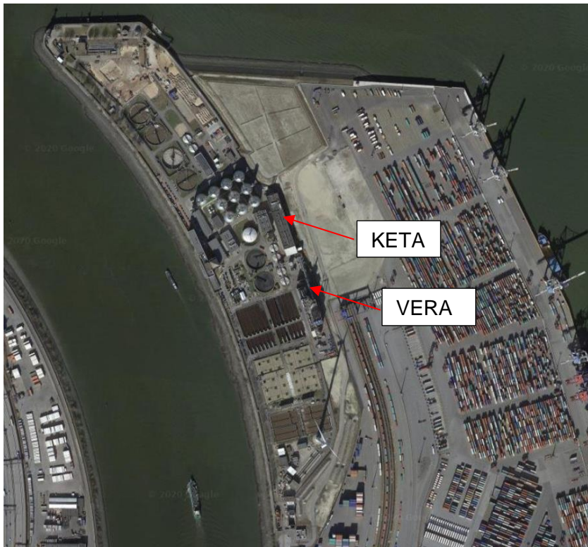
Abbildung 1.2-1: Klärwerk Köhlbrandhäft - ©GoogleMaps
