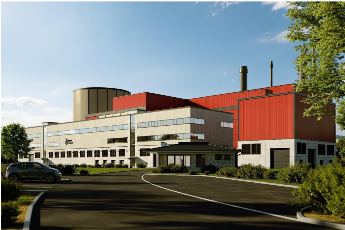
Abb. 1-1: Ansicht der KWK-Anlage Dradenau von der Dradenustraße
