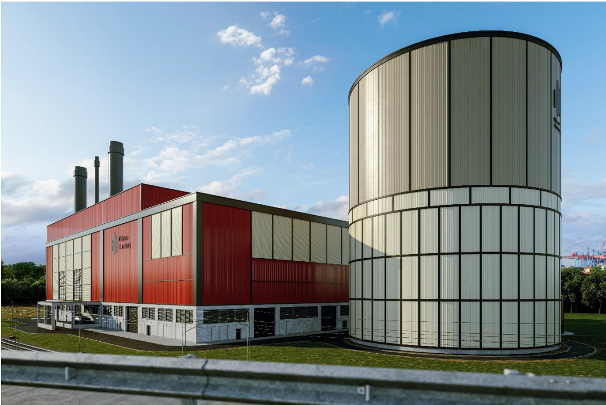
Abb. 1-2: Ansicht der KWK-Anlage Dradenau aus Richtung der Autobahn A7
