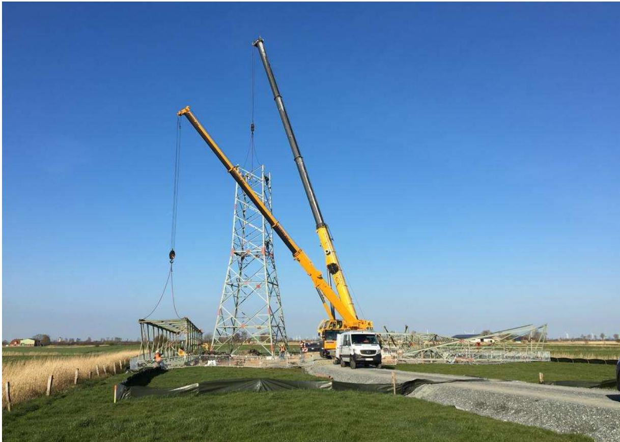
**Abbildung 7: Maststocken mittels Mobilkran (Quelle: 50Hertz)**
