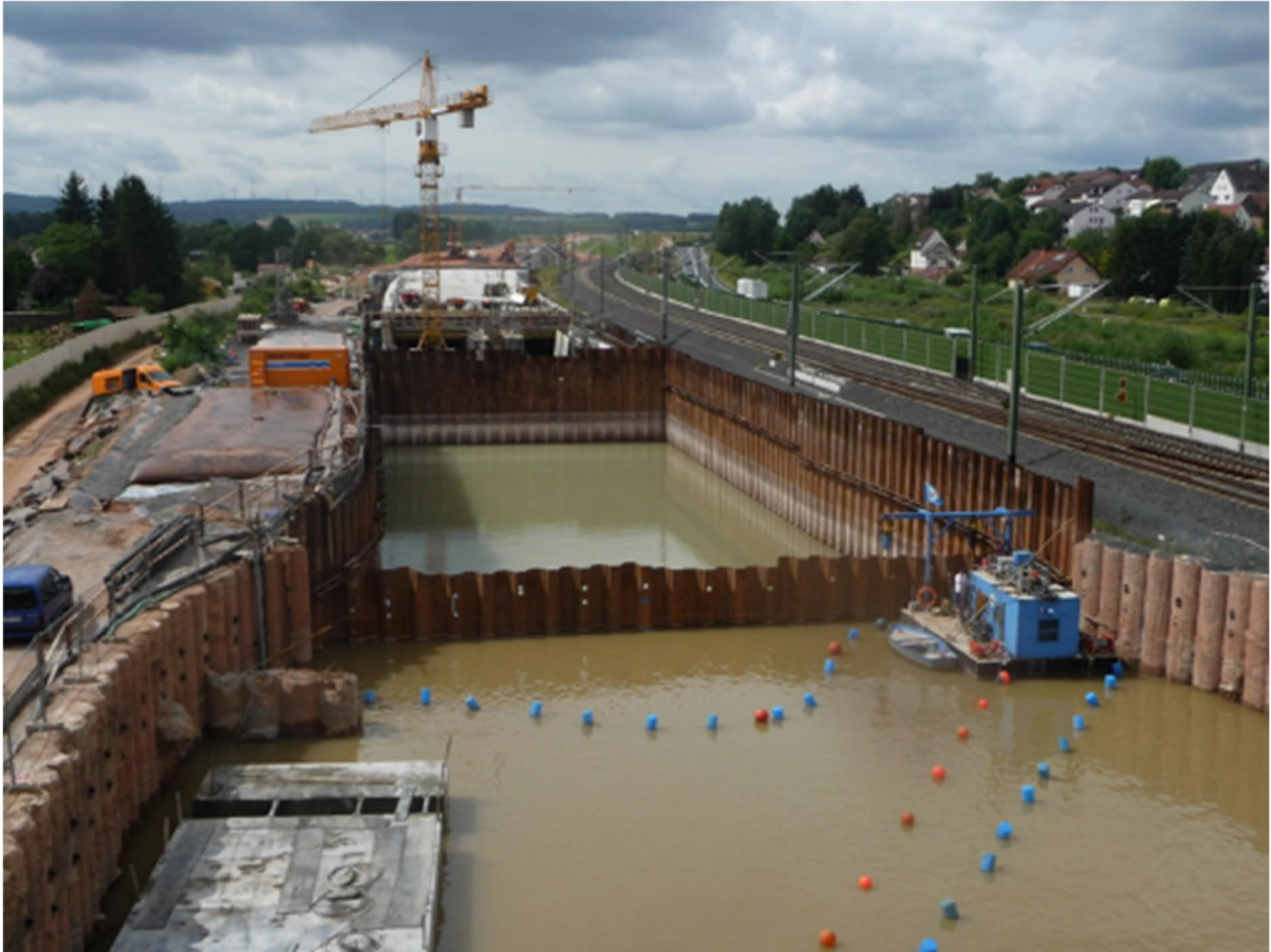
Abb. 11: Beispiel einer Baugrubenwasserbehandlung über geotextile Schläuche, die auf der linken Baugrubenseite lagern (Quelle: Huesker)
