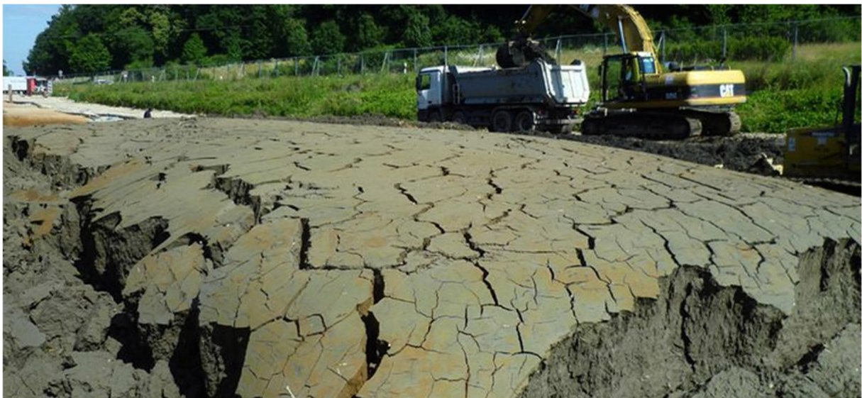
Abb. 14: Geöffneter geotextiler Schlauch mit freigelegtem Filterkuchen (Quelle: Huesker)
