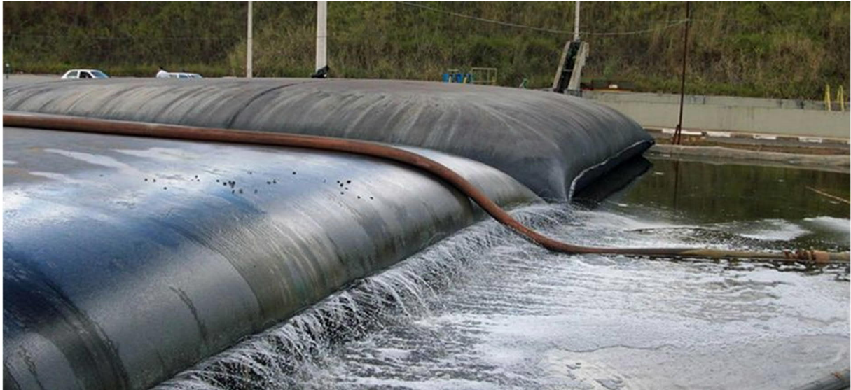
Abb. 13: Geotextiler Schlauch während der Befüllung (Vordergrund) und nach der Befüllung im Hintergrund (Quelle: Huesker)
