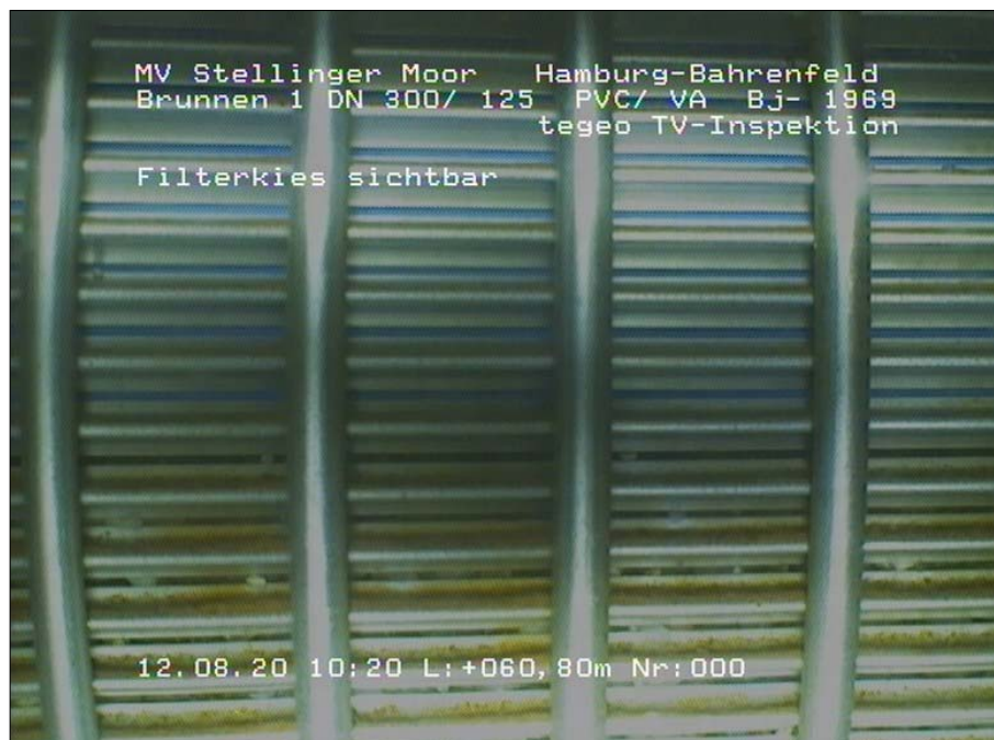
Foto: 1_24A 60,8m, Filterkies sichtbar
