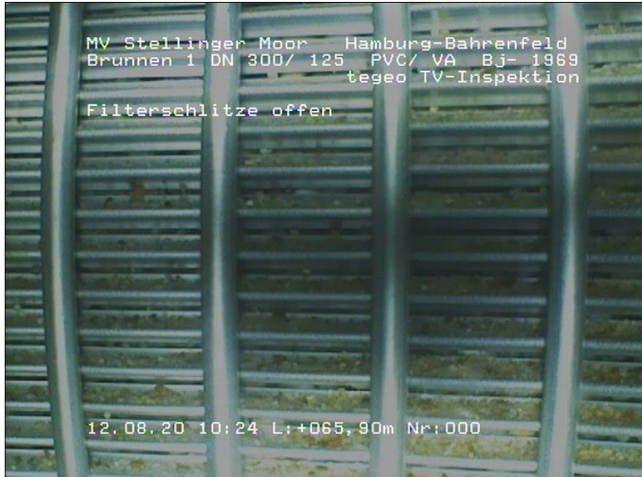
Foto: 1_26A 65,9m, Filterschlitzte offen
