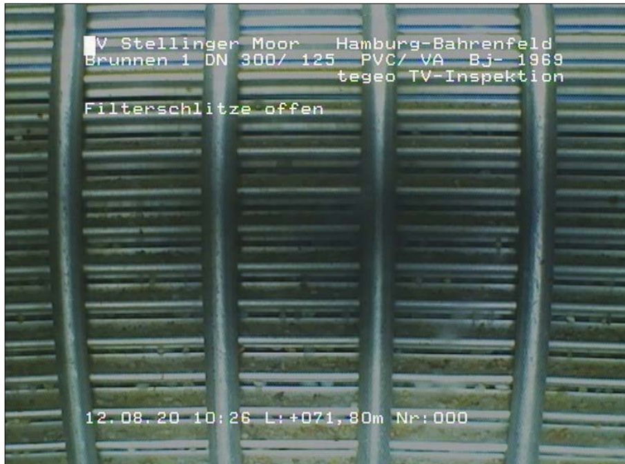
Foto: 1_29A 71,8m, Filterschlitzte offen
