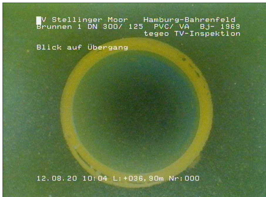
Foto: 1_12A 36,9m, Blick auf Übergang
