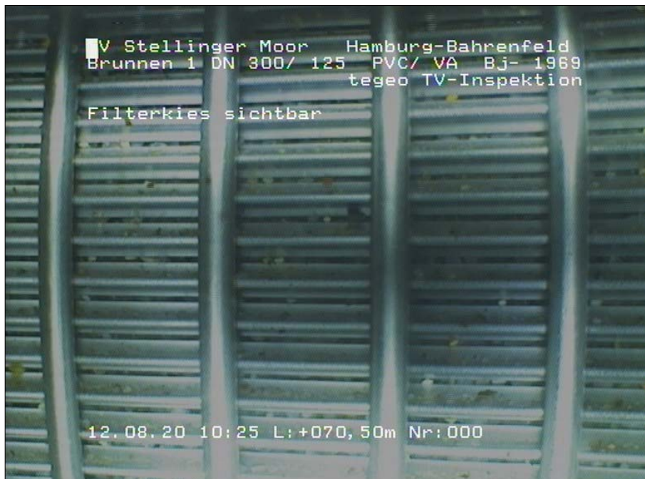
Foto: 1_27A 70,5m, Filterkies sichtbar
