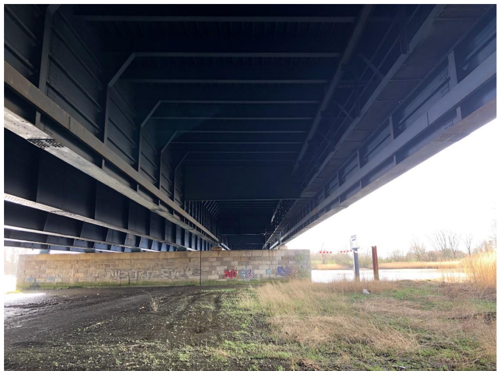
Abbildung 6.3 Das Foto zeigt den bestehenden Brückenpfeiler an der Stelle, an der der Pfeiler 50 errichtet werden soll.
