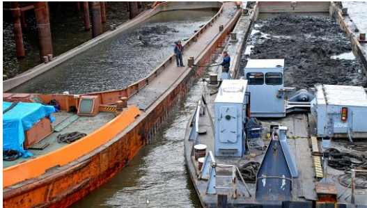
Abbildung 15: Binnenschiffe / Schuten für An- und Abtransport von Nassaushub und Wasser (Auspumpen der Baugruben) (zur Veranschaulichung) (UL 16.2)
