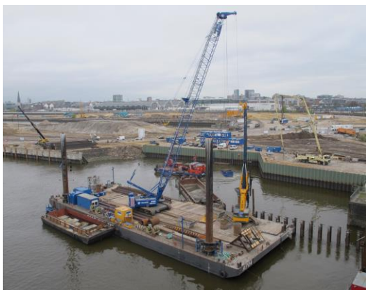
Abbildung 13: Stelzenponton mit Baumaschinen (zur Veranschaulichung) (UL 16.2)
