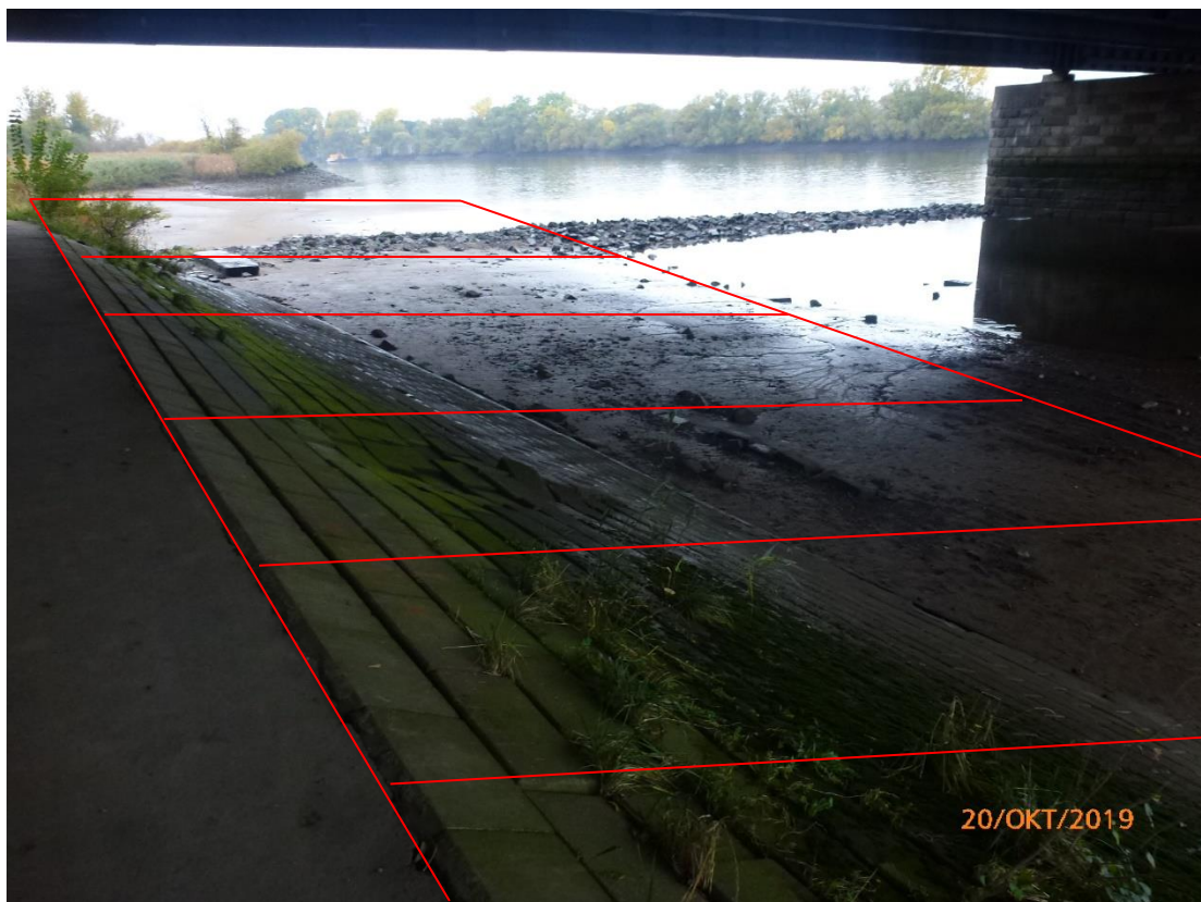
Foto 5: LRT 3270 am südlichen Bestandspfeiler der Süderelbbrücke (A1) mit schematischer Darstellung der Arbeitsinsel
