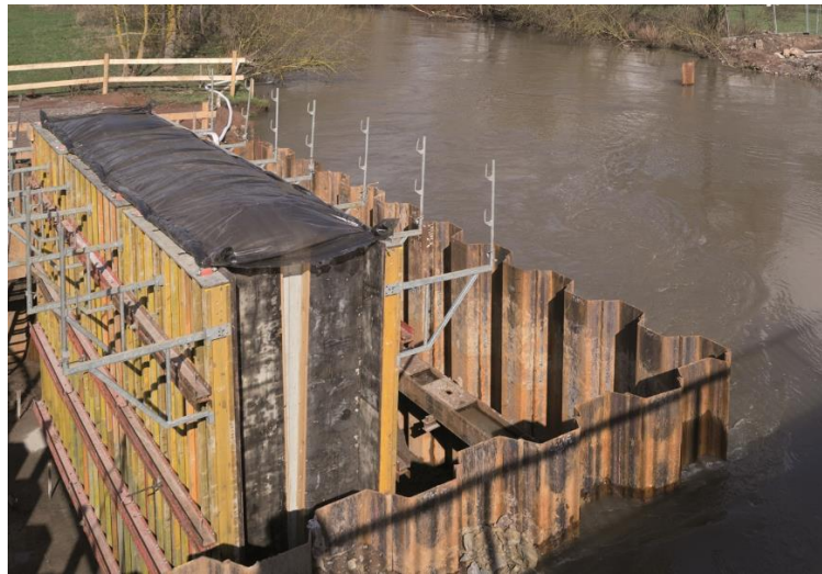
Foto 4: Beispielbild: Pfeiler in geschlossener Spundwandbaugrube (Quelle: UL 16.2, Bau- und Logistikkonzept)
