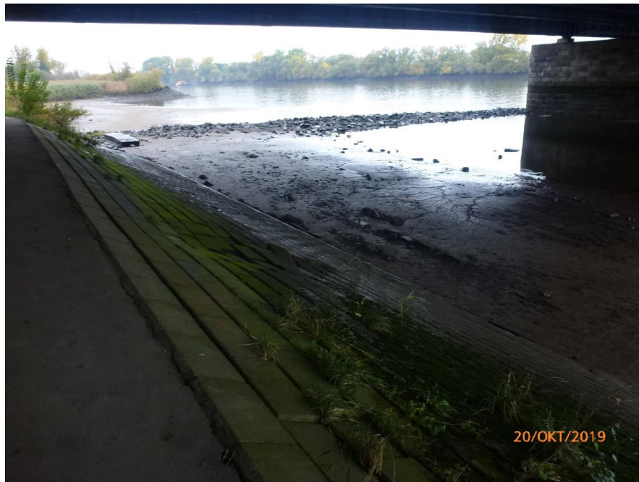
Foto 7: der Südliche Bereich des Gewässerrandstreifens unterhalb des Bestandsbauwerks ist bereits mit Wasserbausteinen verbaut
