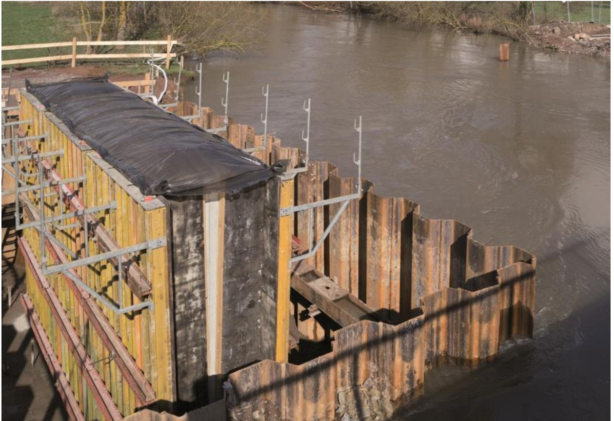
Abbildung 12 Beispielbild: Pfeiler in geschlossener Spundwandbaugrube (Quelle: Internet)
