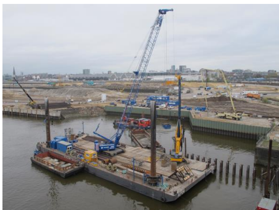
Abbildung 7: Stelzenponton mit Baumaschinen (zur Veranschaulichung, Quelle: Internet)
