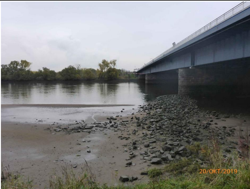
Foto 16: der im Einflussbereich der vorhandenen Süderelbbrücke gelegene LRT 3270 westlich des Bestandsbauwerks südliches Ufer und vorhandener Kolkschutz (aufgenommen am 20.10.2019)
