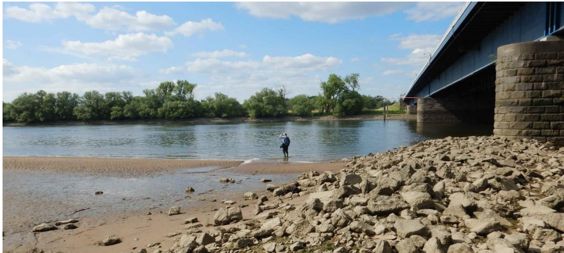
Foto 22: Die Ufer am Südufer der Süderelbe sind im geplanten Baufeld ebenfalls größtenteils mit Wasserbausteinen befestigt und haben keine Eignung als Standort für den Schierlings-Wasserfenchel (Foto: 05/2020).
