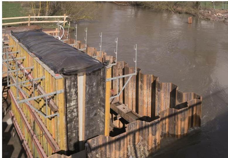
Foto 6: Beispielbild: Pfeiler in geschlossener Spundwandbaugrube (Unterlage 16.2)
