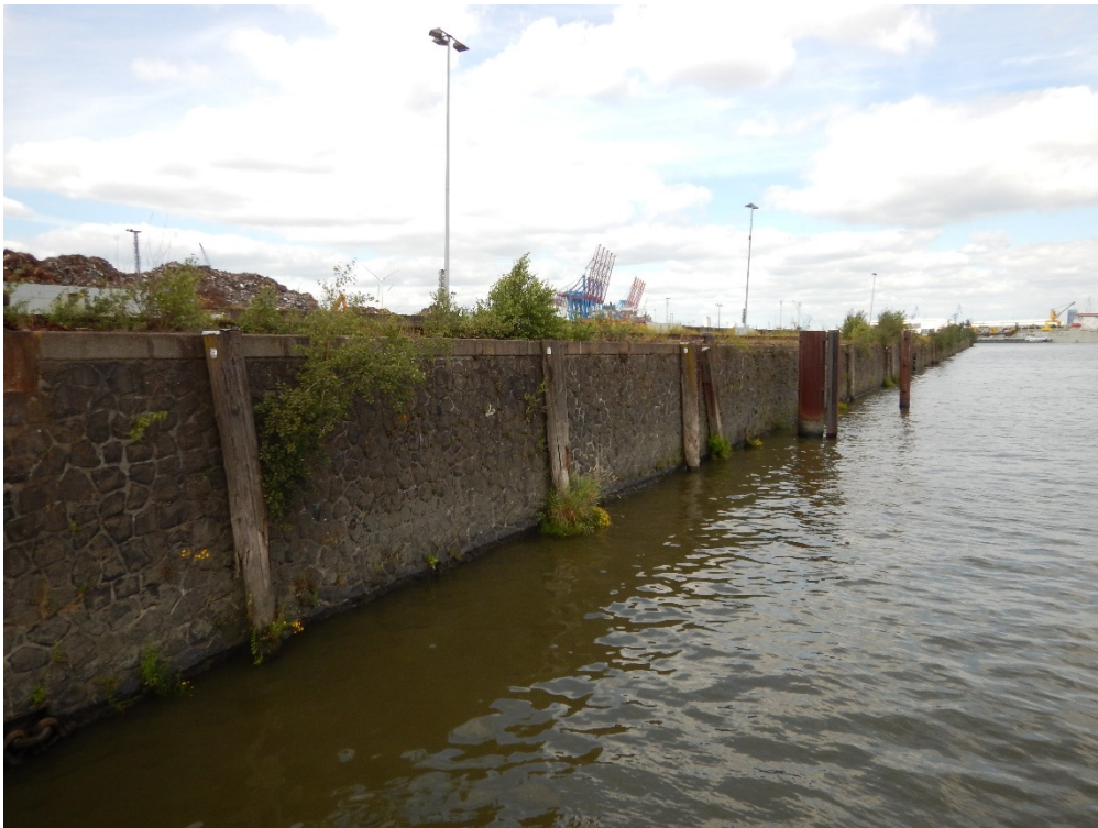
Abb. 17: Alte Kaimauer am Chilekai (östliche Seite des Roßterminals) mit Fugenvegetation (Teil XIV a des Antrags auf Planfeststellung)
