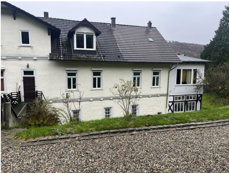
Abb. 10: Wohn- und Geschäftshaus Gut Freienhagen-1 (Gutshaus) Oben: Südostansicht mit Südost- und Südfassade Unten: Südwestansicht mit Südwestfassade
