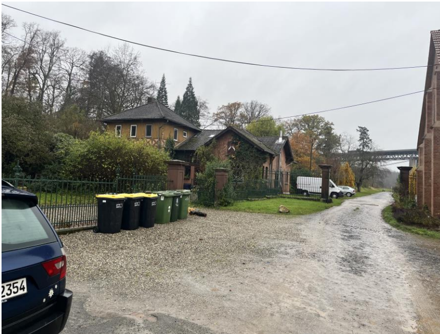
Abb. 6: Wohnhaus Gut Freienhagen-1 (Wohnhaus 1)
