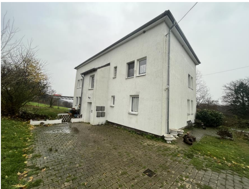
Abb. 9: Wohnhaus Gut Freienhagen-2 (Wohnhaus 4) Südansicht mit Südwestfassade und Südostfassade
