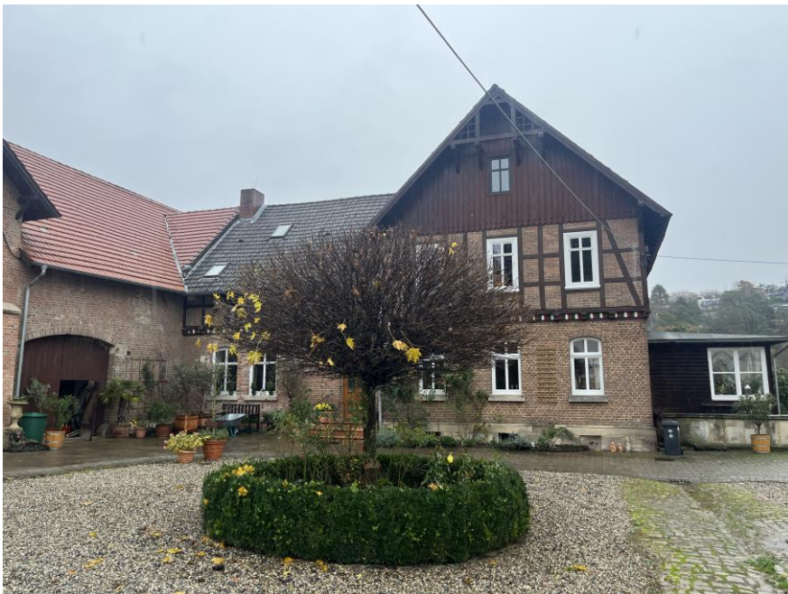
Abb. 7: Wohnhaus Gut Freienhagen-1 (Wohnhaus 2)
