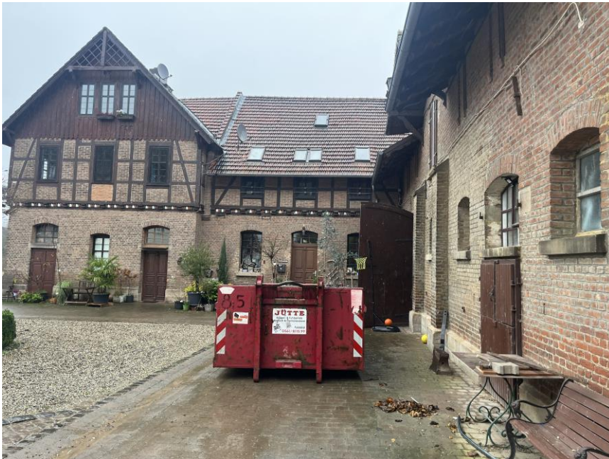
Abb. 8: Wohnhaus Gut Freienhagen-1 (Wohnhaus 3) links: Südwestansicht Wohnhaus mit westlichen Fassadenteilen rechts: Nordseite Scheune
