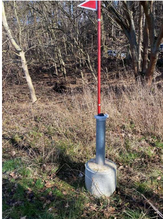
Abbildung 10: Grundwassermessstelle GWM 7_4 B
