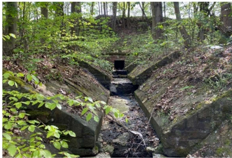
Abbildung 62: Blick Richtung Osten auf den Auslauf der Autobahntwässerung der A 7
