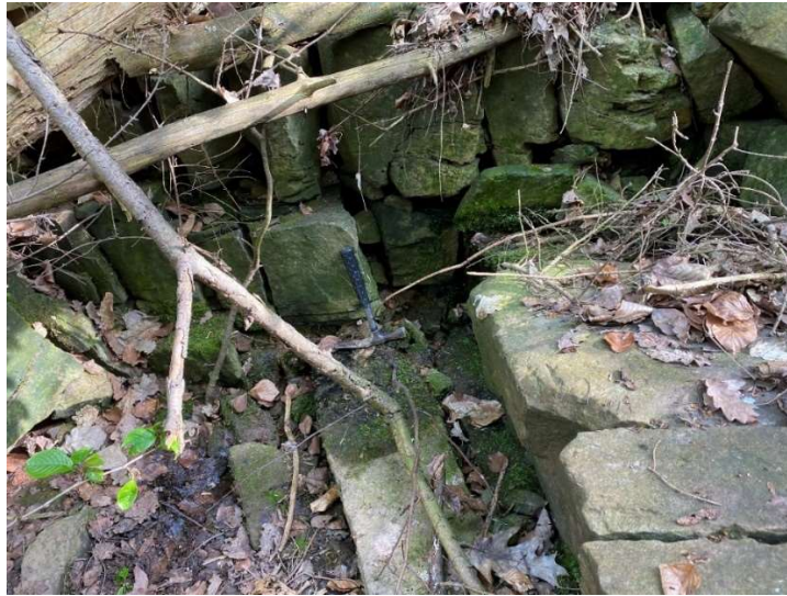
Abbildung 24: Gebankter und geklüfteter Sandstein der Hardeggen-Formation im nördlichen Geländeeinschnitt des Fulda-Steilhangs
