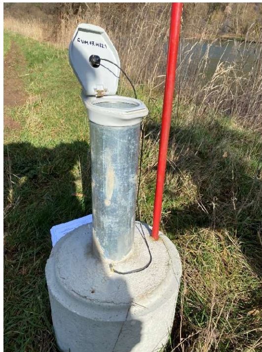
Abbildung 11: Grundwassermessstelle GWM 07H 82_1
