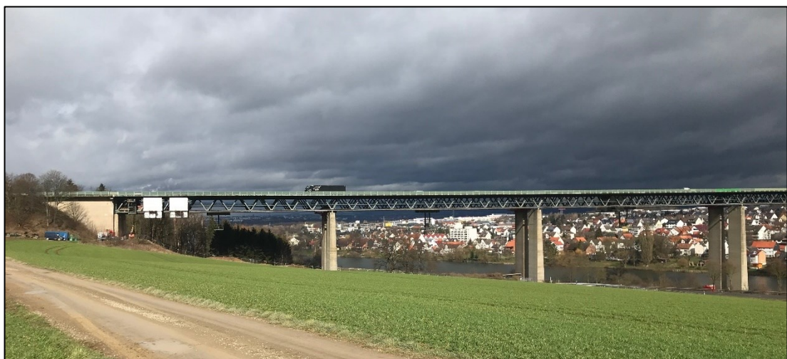
Abb. 46: Bergshäuser Brücke aus dem Blickwinkel der Reitanlage des Gutes Freienhagen;
