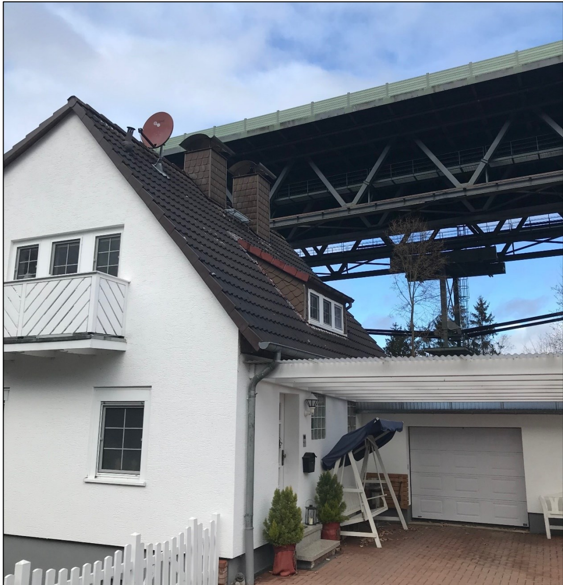
Abb. 20: Bestehende Bergshäuser Brücke in der Ortslage Bergshausen;
