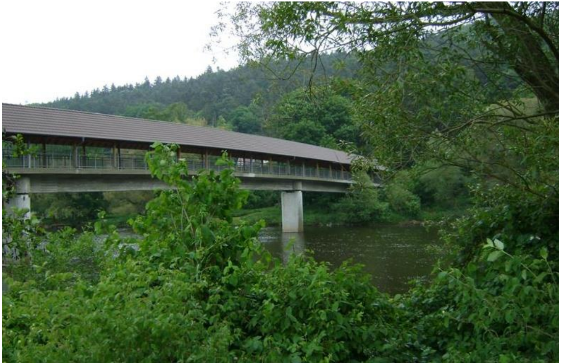
Abbildung 18: Wander- und Radwegebrücke über die Fulda bei den Sperrenhäusern südlich Bergshausen
