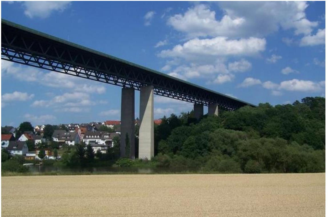
Abbildung 16: Blick auf die Bergshäuser Brücke
