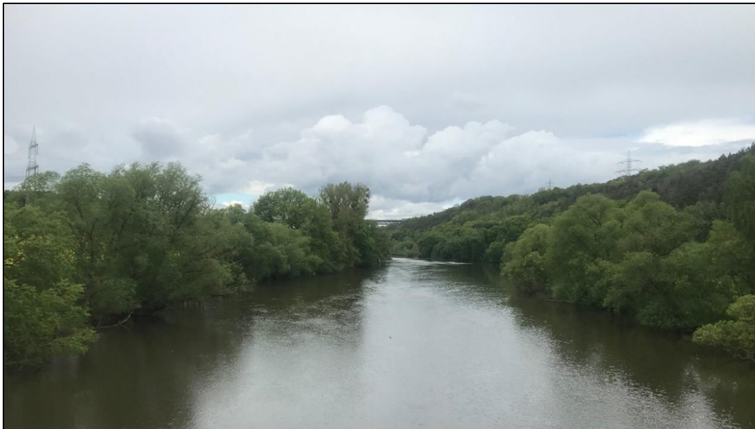
Abb. 2: Blick von der Fußgängerbrücke bei der Sperre Siedlung in Richtung Bergshäuser Brücke
