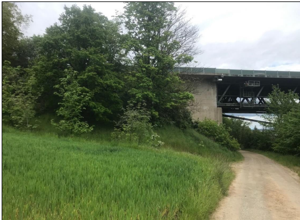
Abb. 13: Widerlager West, Blick von Süden nach Norden
