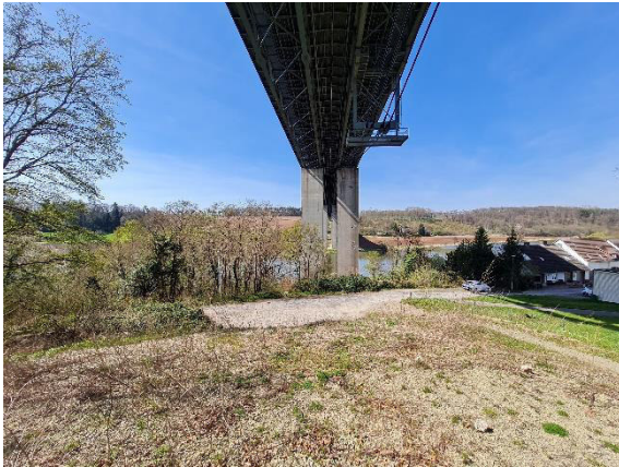
Aufnahme von BW07 vom Ostufer in Richtung Westen; nördlich der Brücke sind Wohneinheiten der Ortschaft Bergshausen zu sehen
