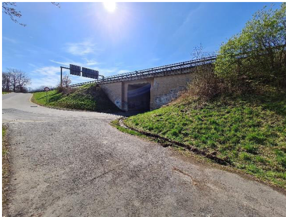
Aufnahme von BW03 in Richtung Südosten
