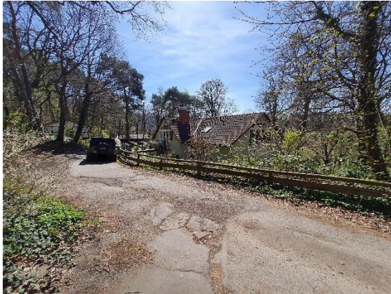
Aufnahme vom Standort der Bergshäuser Brücke in Richtung Süden; rechts im Bild ist das Gebäude der Uferstraße 15
