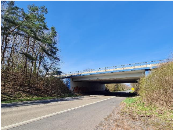
Aufnahme von der Brücke BW08 über die Landesstraße L3460, aufgenommen in Richtung Norden
