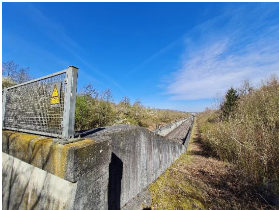
Aufnahme von BW01.1 in Richtung Norden
