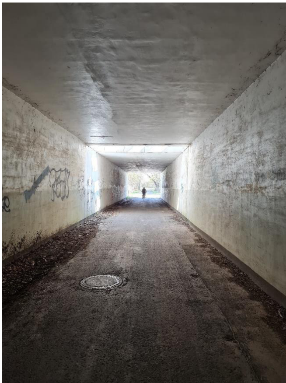
Aufnahme unter BW01 in Richtung Norden
