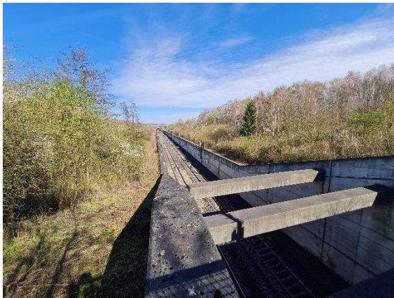
Aufnahme von BW01.1 in Richtung Norden
