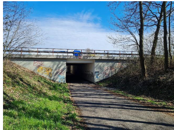
Aufnahme von BW01 in Richtung Norden
