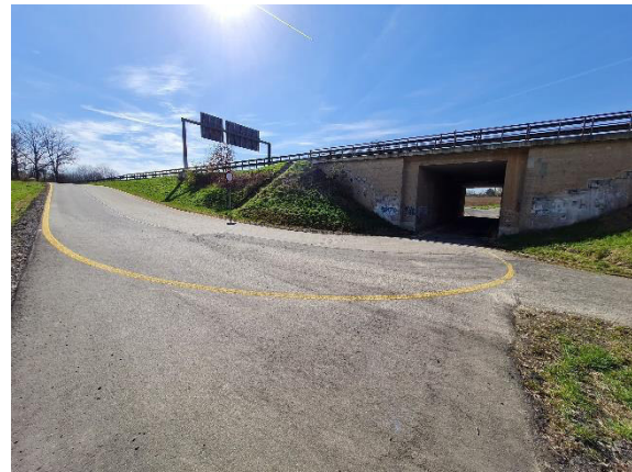
Aufnahme von BW03 in Richtung Südosten
