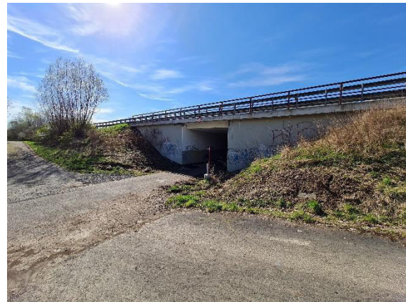
Aufnahme von BW01 in Richtung Südosten
