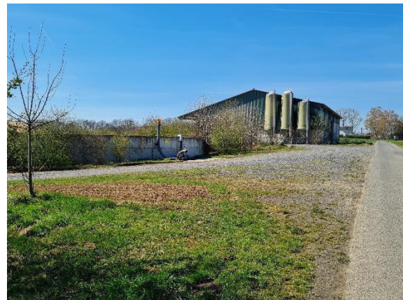
Aufnahme von Gebäude Südwestlich von BW05
