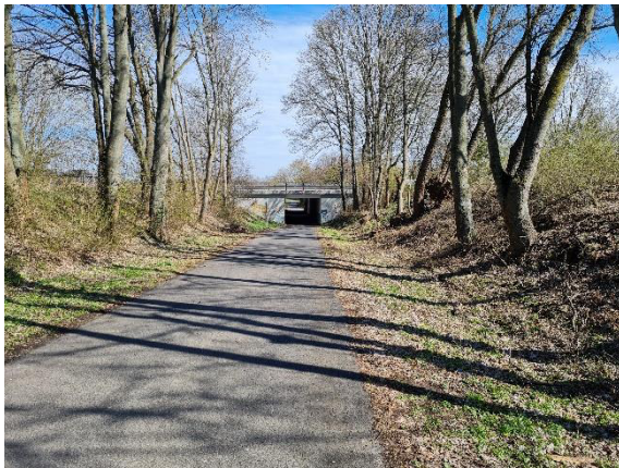
Aufnahme von BW01 in Richtung Norden
