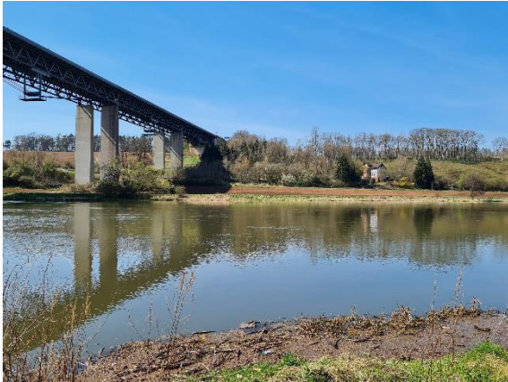
Aufnahme vom Ostufer in Richtung Westen. Im Norden der Brücke befindet sich das Gebäude Gut Freienhagen 3
