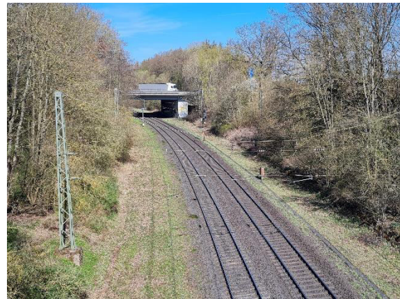
Aufnahme von BW04 in Richtung Norden
