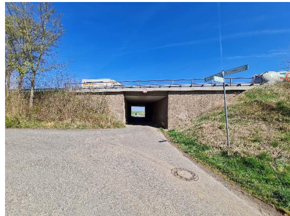
Aufnahme von BW05 in Richtung Norden
