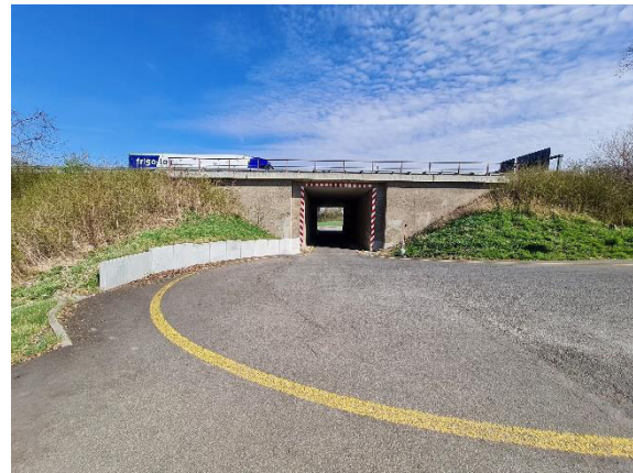
Aufnahme von BW03 in Richtung Norden
