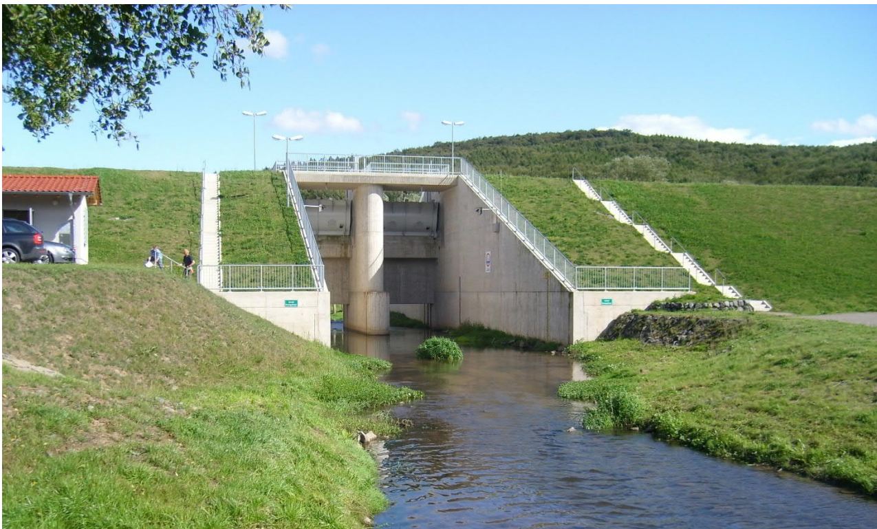
Abbildung 3.2: Auslassbauwerk HRB Ehringen mit ähnlichem Bauwerkskonzept
