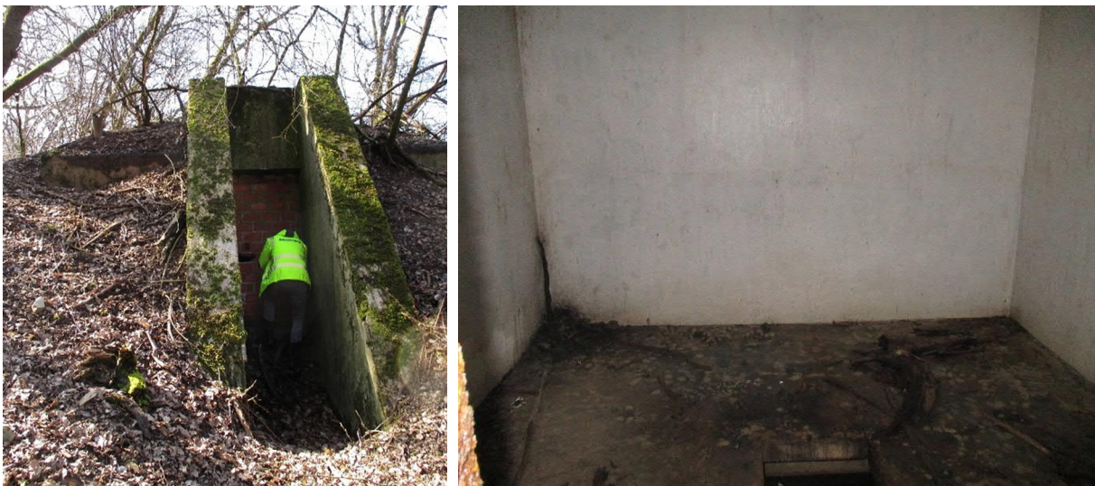
Abbildung 5.1: Stillgelegter Tiefbrunnen der ehemaligen Munitionsfabrik
