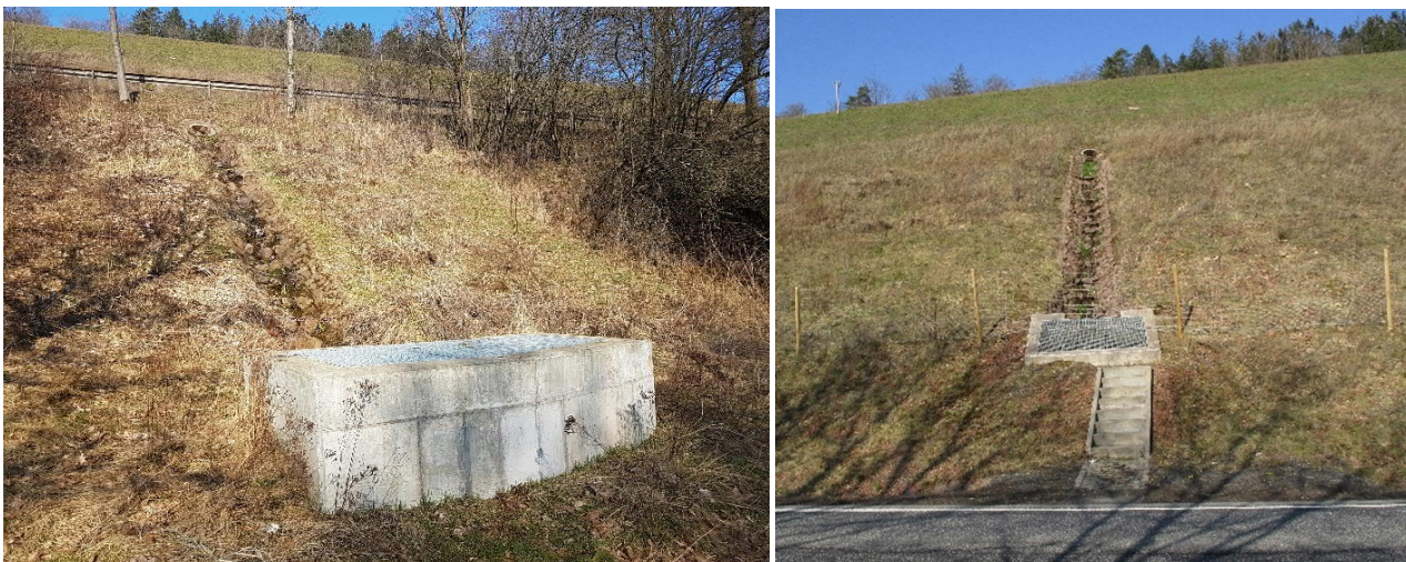
Abbildung 5.2: Entwässerungsbauwerk der A44, links unterhalb der B7, rechts oberhalb der B7
