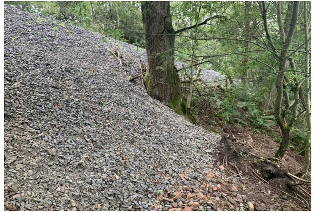
Abb. 8: Überschüttete Hangrutschung an der Bahnböschung (August 2019).
