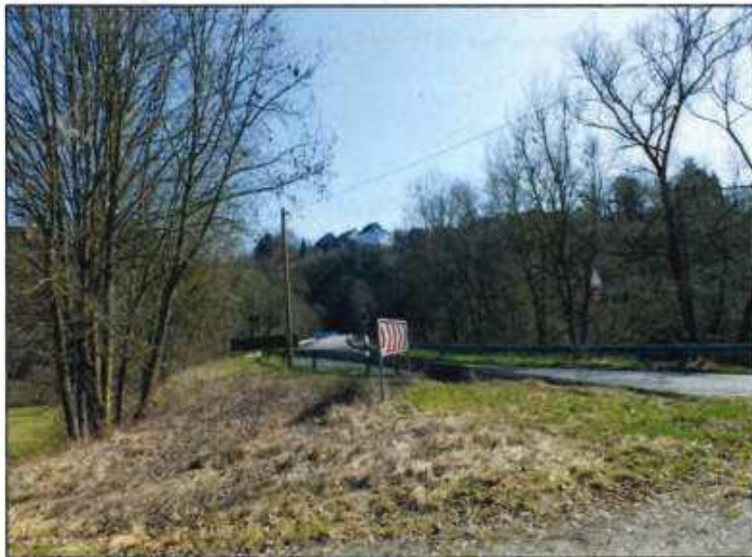
Abbildung 1: einspurige Lahnbrücke mit Lichtsignalsteuerung
