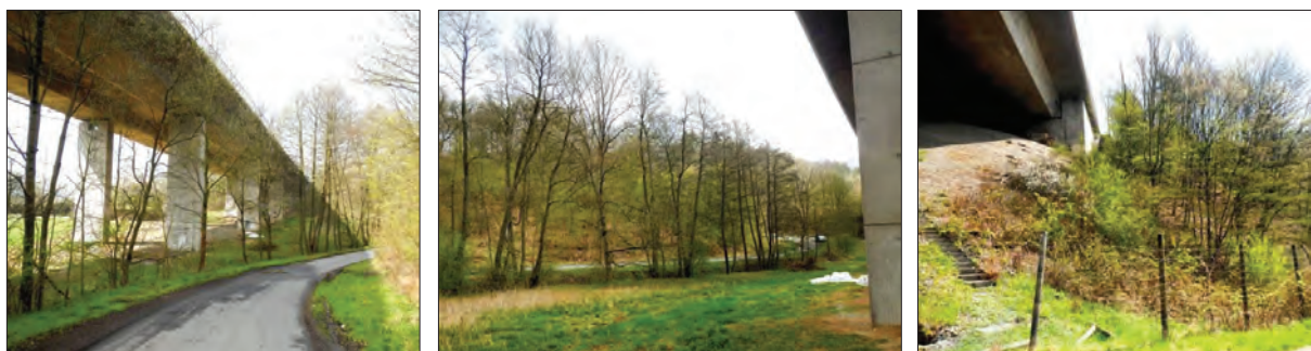
Abbildung 4: Bäume im Bereich der Kreuzbach Talbrücke wurden auf Fledermausquartiere untersucht (Fotos V. Bellen)
