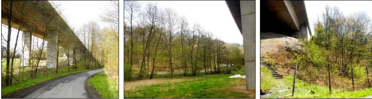
Abb. 4 Bäume im Bereich der Kreuzbach Talbrücke wurden auf Fledermausquartiere untersucht (Fotos: V. Bellen)
