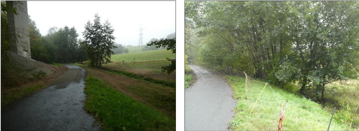
Abbildung 8: Talbrücke Kreuzbach mit Blick auf den nachfolgenden Gewässerabschnitt
