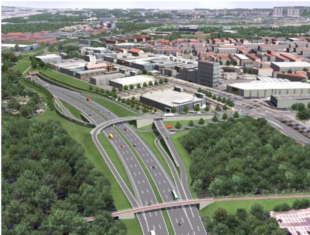
Bild 3: Visualisierung der geplanten AS „Borsigallee“<sup>1</sup> aus östlicher Richtung betrachtet. Am linken Bildrand ist das Ostportal zu erkennen. In der Bildmitte sieht man das P+R Parkhaus<sup>2</sup>. Quelle: [www.riederwaldtunnel.de](http://www.riederwaldtunnel.de)
