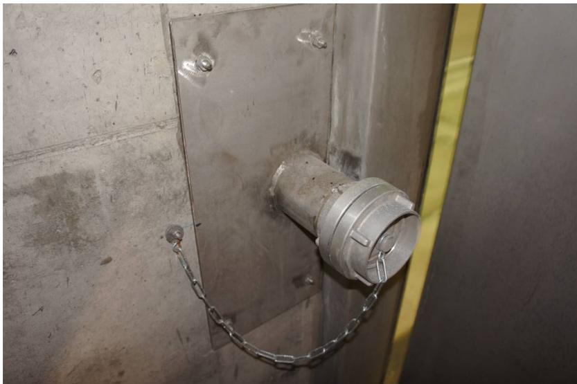
Abbildung 11: Bsp. trockene Löschleitung als Wanddurchführung in einem Tunnel, DN 80 mit B-Festkupplung beidseitig neben einem Notausgang, Quelle: SW IB BS GmbH
