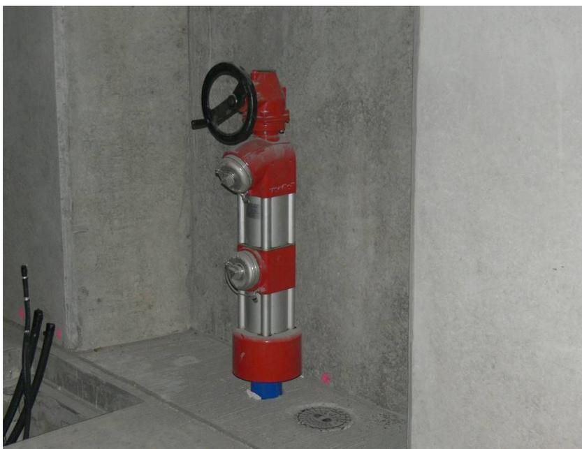
Abbildung 9: Bsp. Hydrant in Hydrantennische Tunnel
