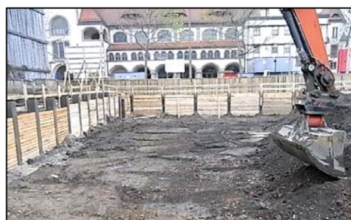
Abb. 4. Schichtenweiser Abtrag, verpflichtend bei baubegleitender KMR
