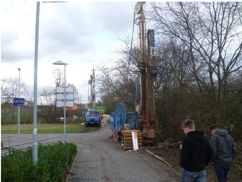
Bild 6. EÜ Westerbach, Bohrpunkt BK 1-89 (hinten) und BK 1-92 (vorne)
