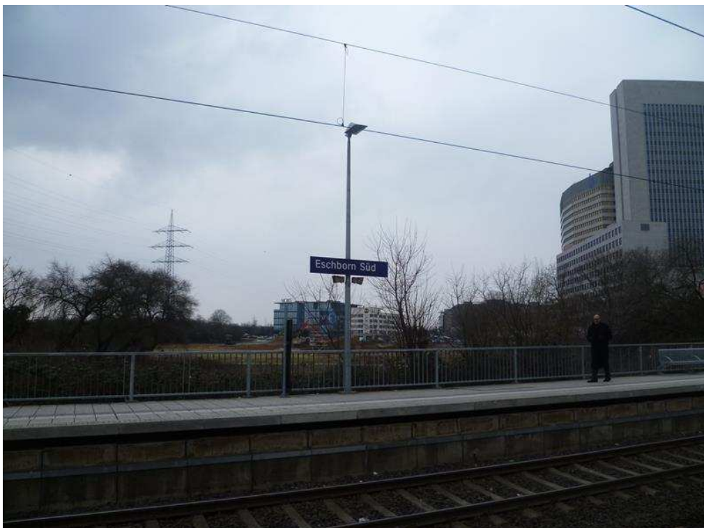
Bild 8. EÜ über S-Bahn 3615, Hp Eschborn Süd, Blick Richtung Südwest
