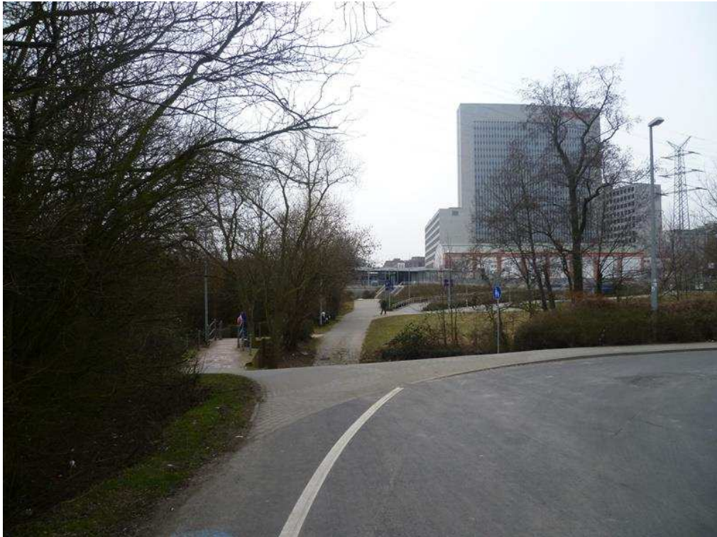
Bild 3. EÜ Westerbach, Blick Richtung Hp Eschborn Süd
