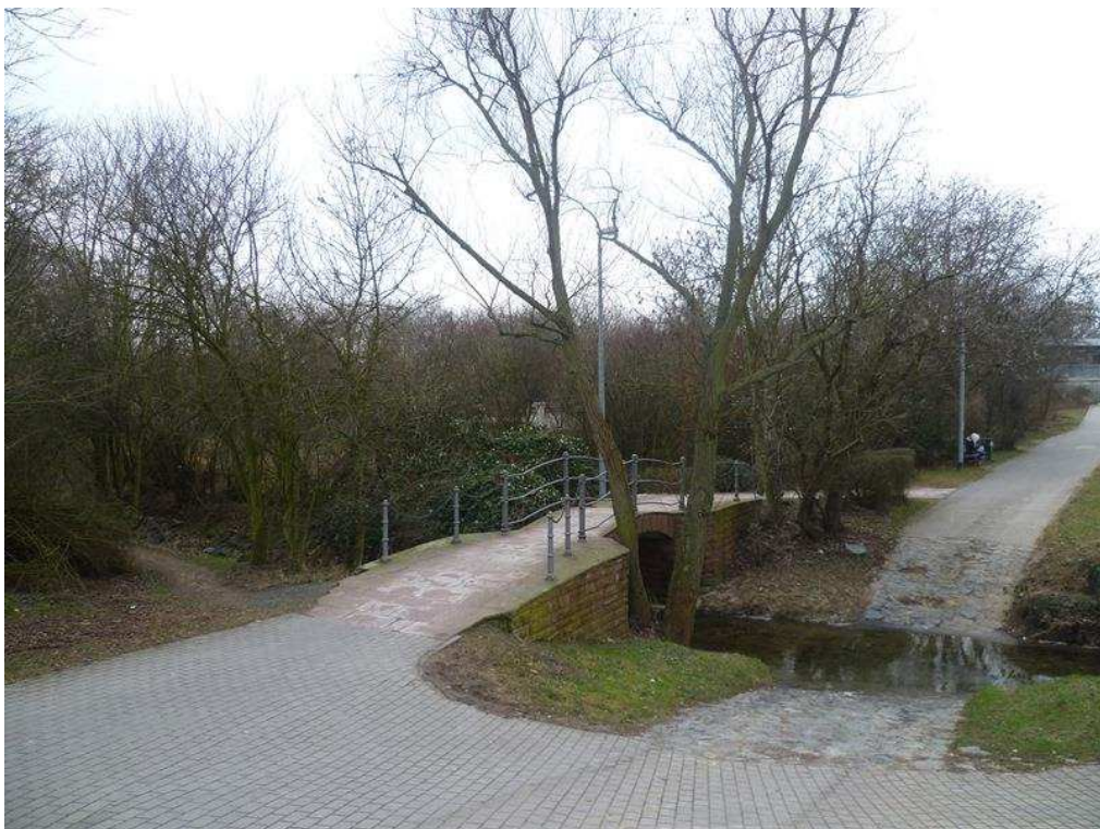
Bild 4. EÜ Westerbach, Fuß-/Radweg über Westerbach
