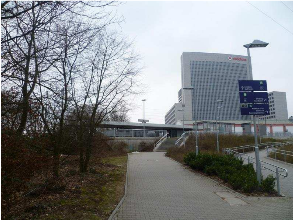
Bild 5. EÜ Westerbach, Blick Richtung Hp Eschborn Süd
