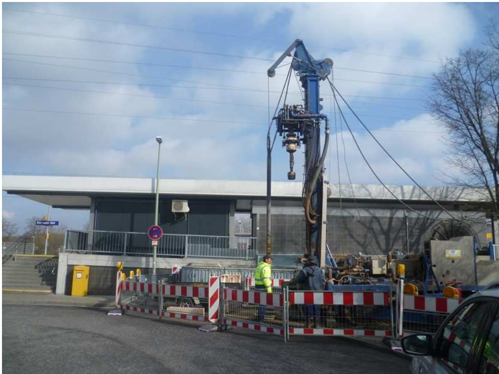
Bild 9. EÜ über S-Bahn 3615, Bohrpunkt BK 1-98
