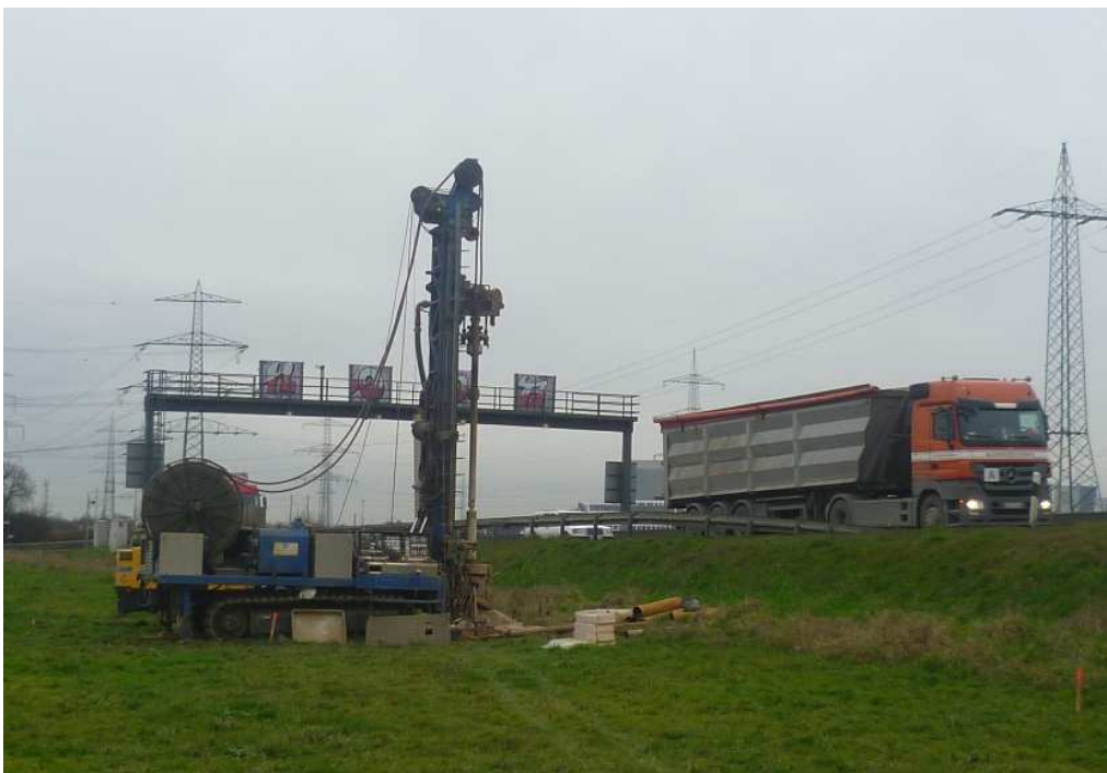
Bild 2. EÜ BAB A5, Widerlagerseite Ost, Bohrpunkt BK 1-22
