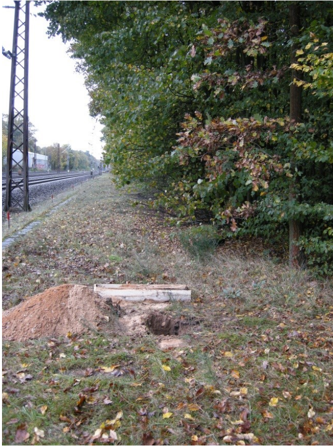
Aushub, Bohrloch und Kernkiste Bohransatzpunkt 6
