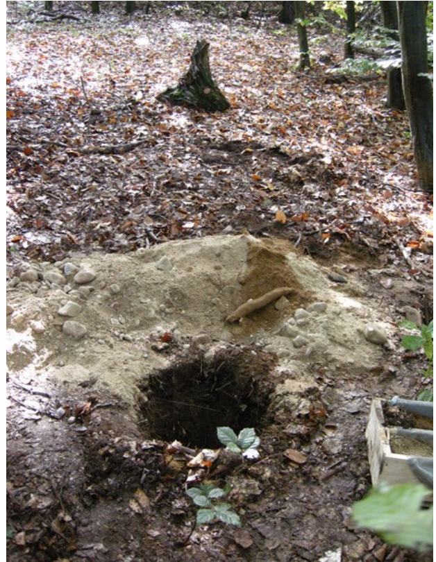
Bohrloch und Aushub Bohrersatzpunkt 2
