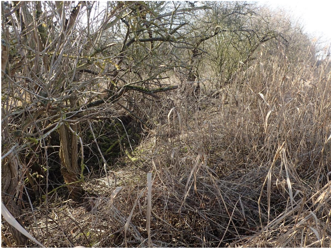
Abbildung 3-4: Graben trocken (Winter), Blick nach Westen – Station 1+277
