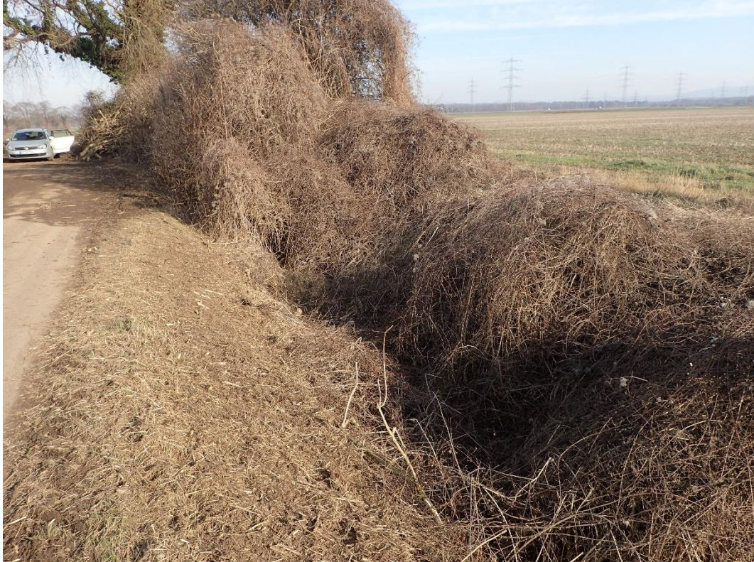
Abbildung 3-12: Landgraben trocken (Winter), Blick nach Osten – Station 10+246
