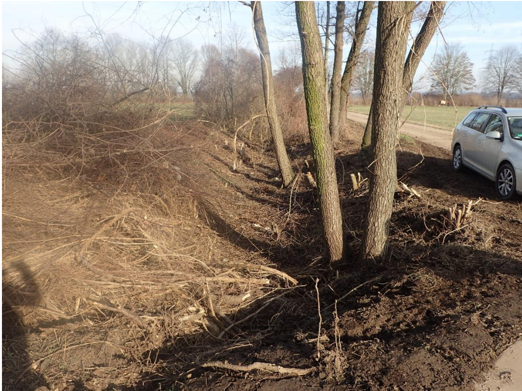
Abbildung 3-13: Graben trocken (Winter), Blick nach Osten – Station 10+815
