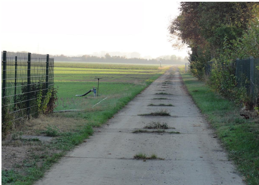
Abbildung 2-4: Öffentlicher Weg an der Nordseite des WW Allmendfeld (Blick nach Osten)
