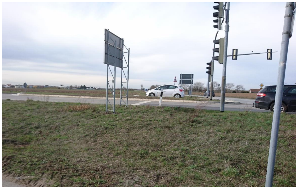
Abbildung 2-11: Kreuzungsbereich K 149/B 426 - Station 6+108, Blick nach Westen
