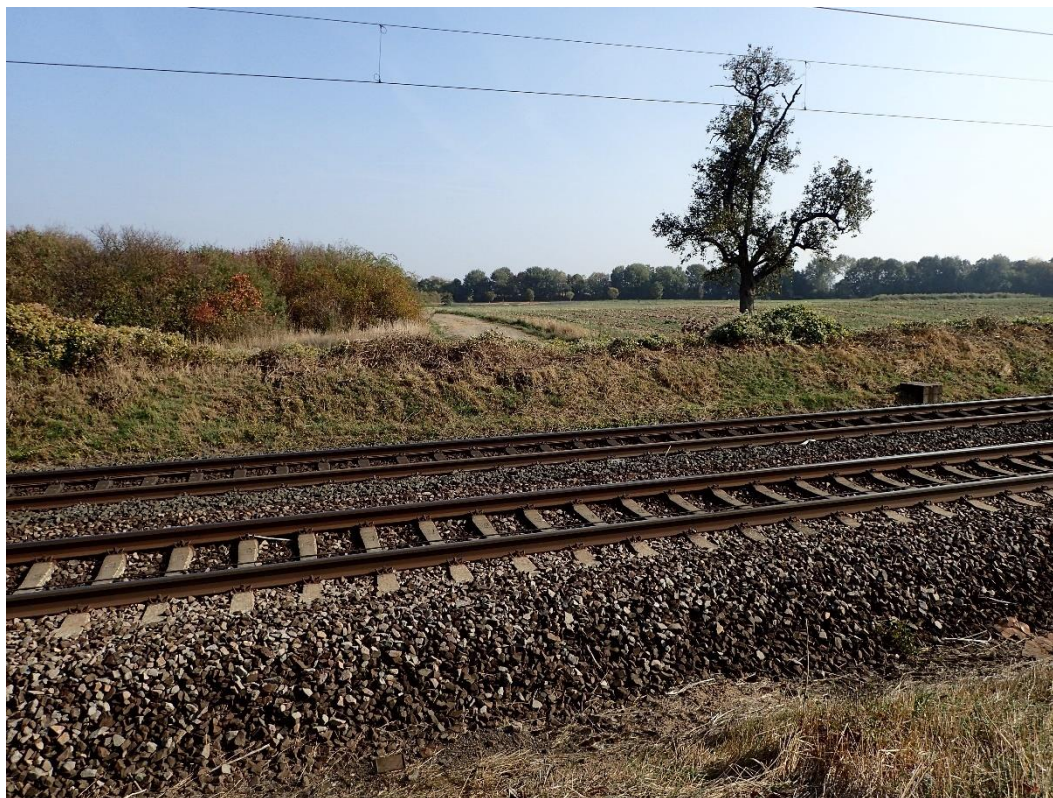
Abbildung 2-18: DB-Bahntrasse „Riedbahn“ - Station 15+768, Blick nach Osten
