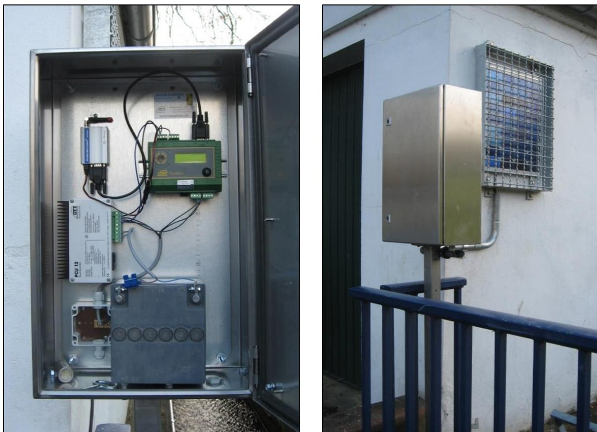
Abbildung 5-9: Schrank für Messtechnik, hier mit Solarpanel (Beispielfoto)
