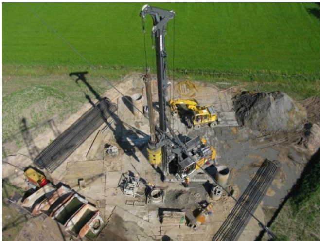
Abbildung 9: Erstellung der Bohrpfähle (beispielhaft)
