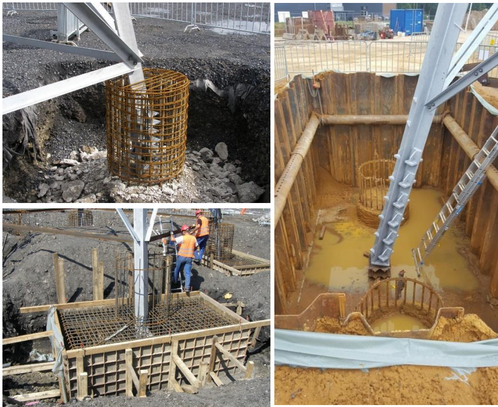
Abbildung 13: Anbindung der Eckpfähle vor dem Betonieren (beispielhaft)
