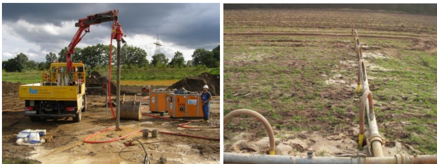
Abbildung 11: Einrichtung der Wasserhaltung mittels Spüllanz (beispielhaft)
