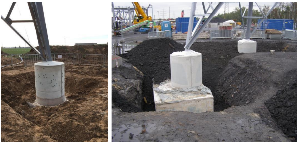
Abbildung 14: Anbindung der Eckpfähle nach dem Betonieren (beispielhaft)
