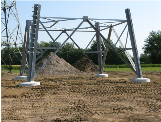
Abbildung 15: Mastfuß nach Errichtung und Anbindung an die Bohrpfähle (beispielhaft)
