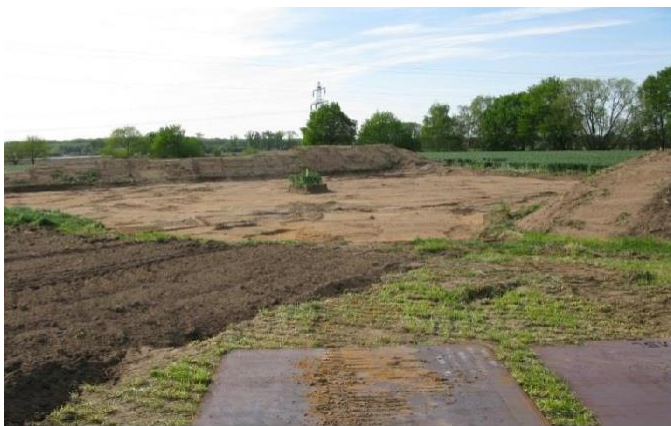
Abbildung 8: Abtrag des Oberbodens (beispielhaft)
