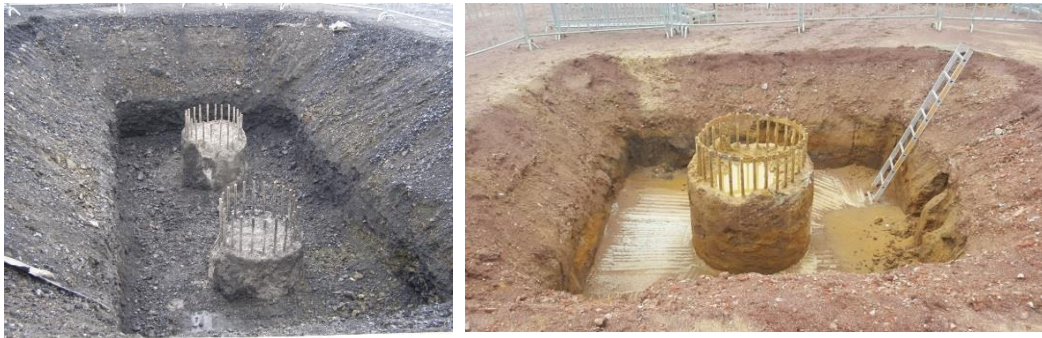
Abbildung 10: Freilegen der Bohrpfähle – links Zwillingsbohrpfahl – rechts Einzelbohrpfahl (beispielhaft)
