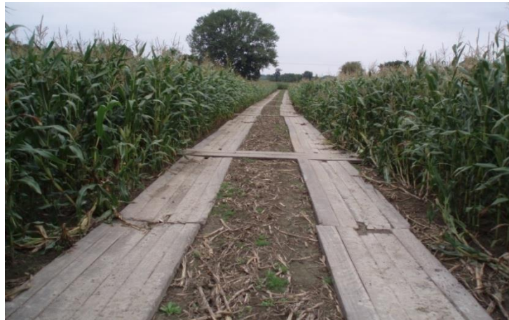
Abb. 1: Temporäre Zuwegung über Fahrbohlen
