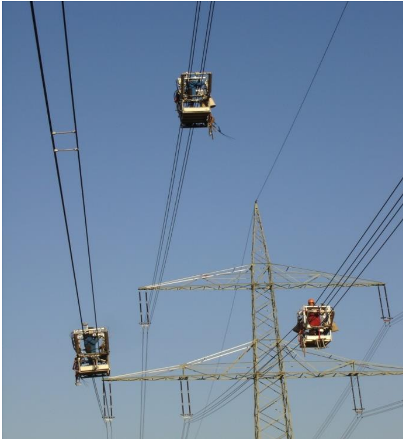
Abb. 10: Montage der Feldbündelabstandhalter mit Fahrwegen
