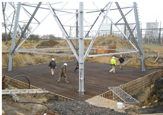
Abb. 4: Montage der Fundamentbewehrung
