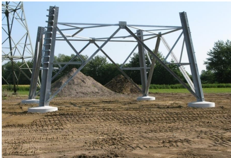
Abb. 5: Montierter Mastfuß
