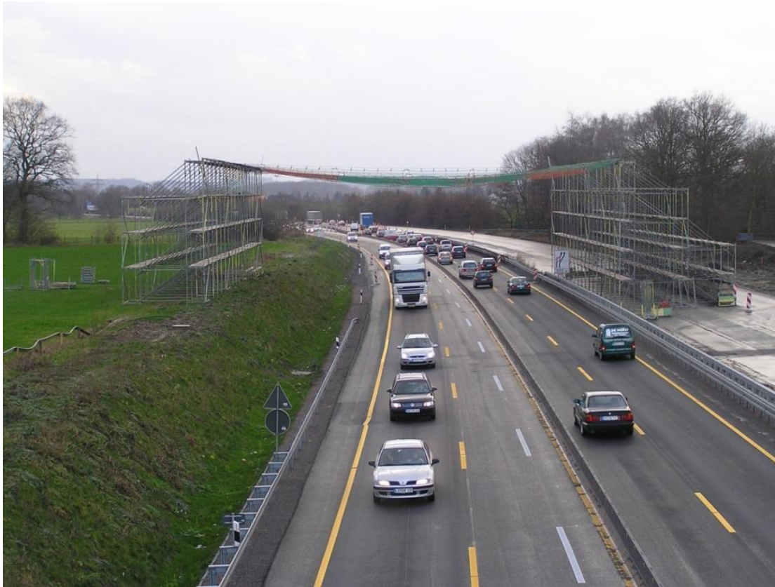
Abb. 8: Stahlrohrschutzkonstruktion mit Netz über einer Autobahn
