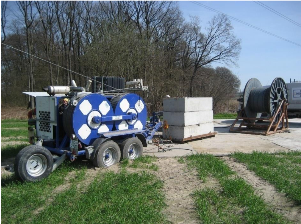
Abb. 9: Windenplatz eines 4er-Bündel-Seilzuges
