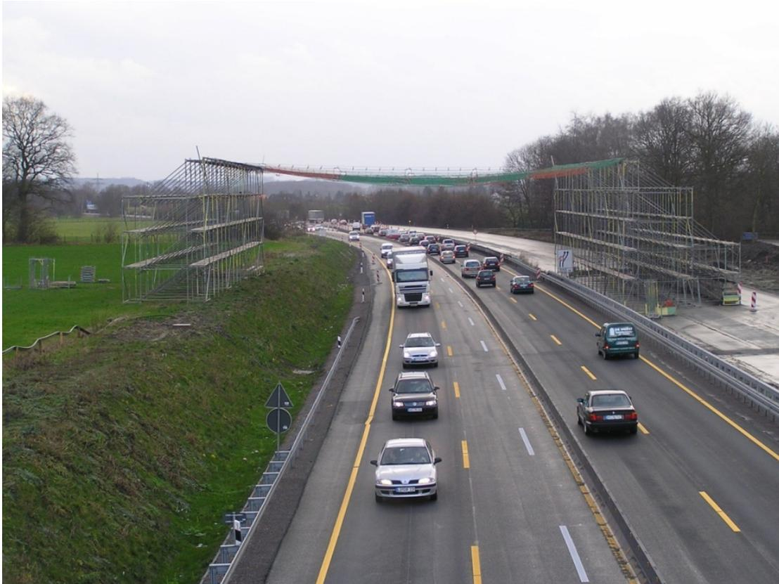
Abb. 8: Stahlrohrschutzkonstruktion mit Netz über einer Autobahn
