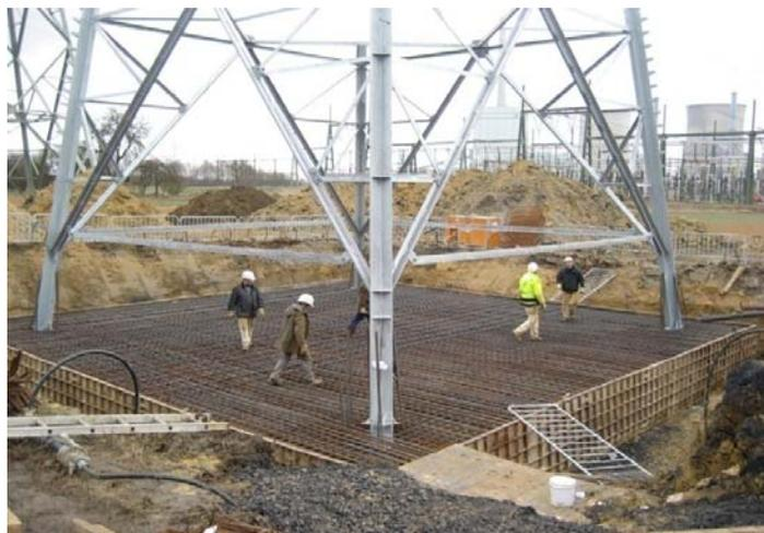
Abb. 4: Montage der Fundamentbewehrung
