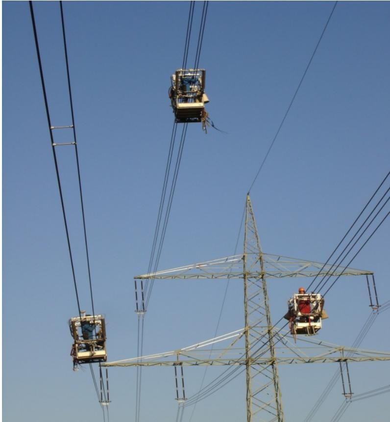
Abb. 10: Montage der Feldbündelabstandhalter mit Fahrwegen
