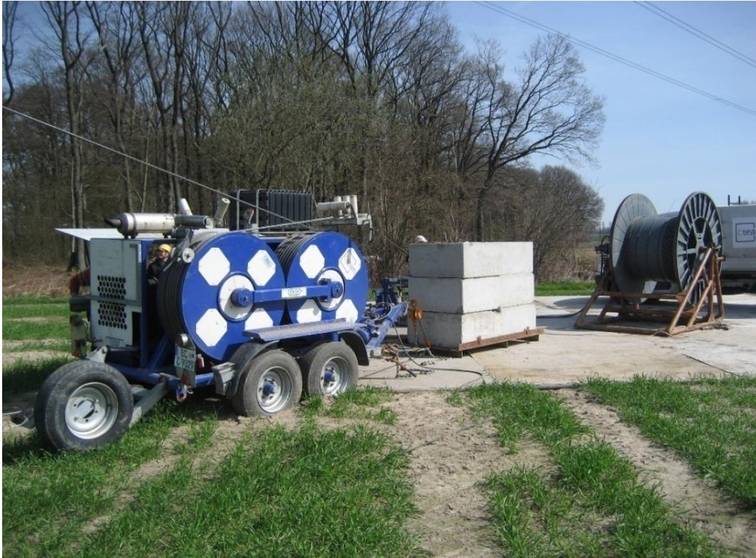
Abb. 9: Windenplatz eines 4er-Bündel-Seilzuges
