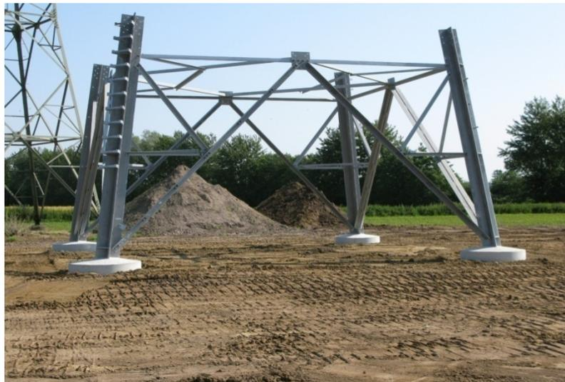
Abb. 5: Montierter Mastfuß
