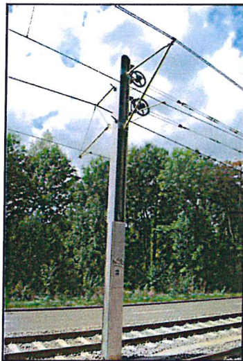
Abbildung 12: Beispiel: Radnachspanner am Mittelmast und Hochkettenfahrleitung der Strecke
