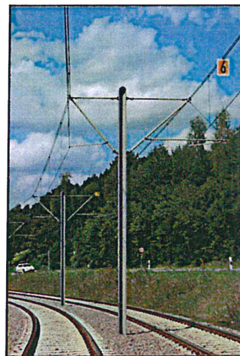
Abbildung 12: Beispiel: Radnachspanner am Mittelmast und Hochkettenfahrleitung der Strecke
