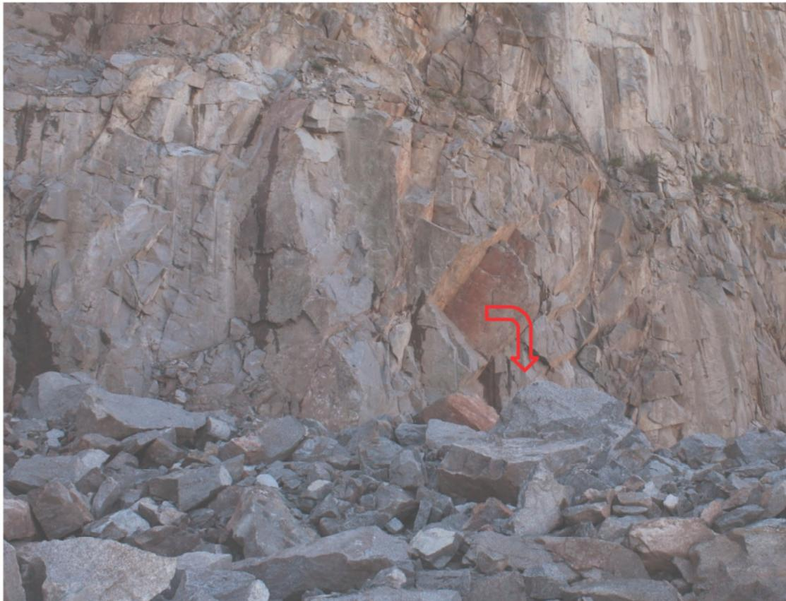
Bild 5.6: aus der Südostwand herausgebrochener Kluftkörper
