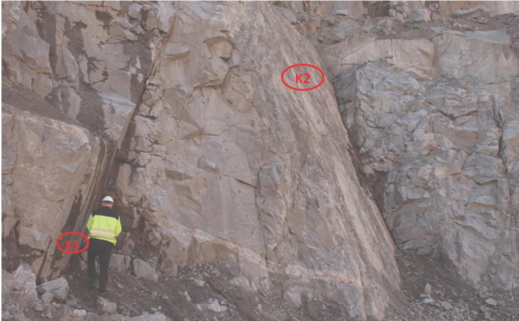
Bild 4.7: Klüfte K2 und K1 in der Südwand
