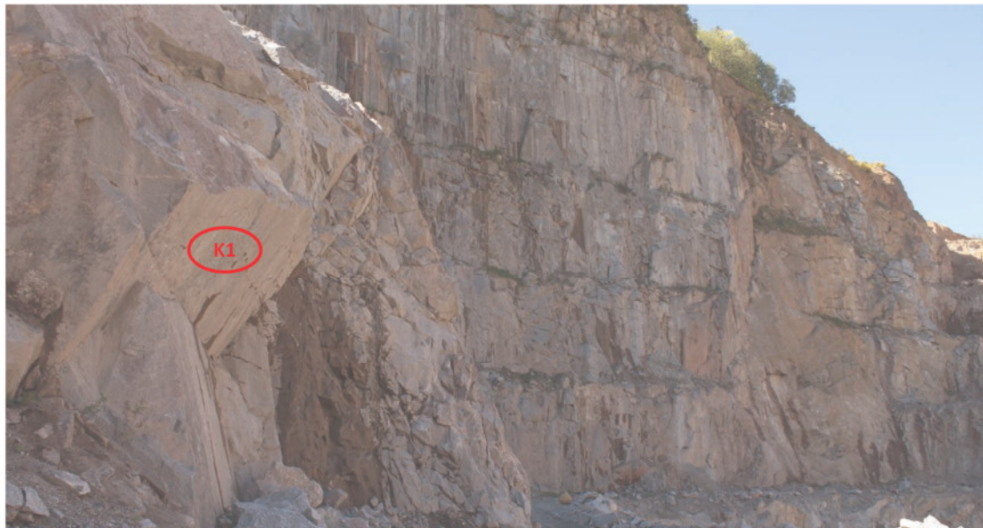
Bild 4.5: Trennflächenschar K1 in der Südwand
