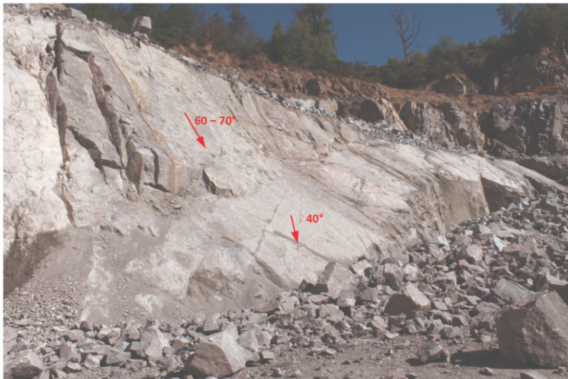
Bild 4.2: Felsböschung auf der NW-Seite oberhalb der Sohle +230
