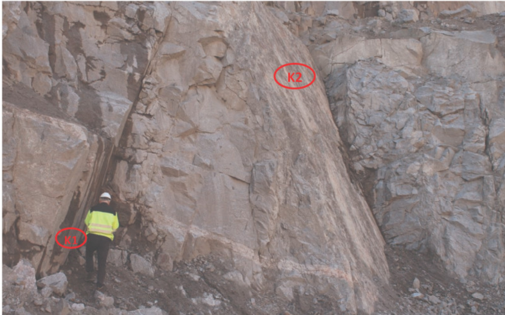
Bild 4.7: Klüfte K2 und K1 in der Südwand
