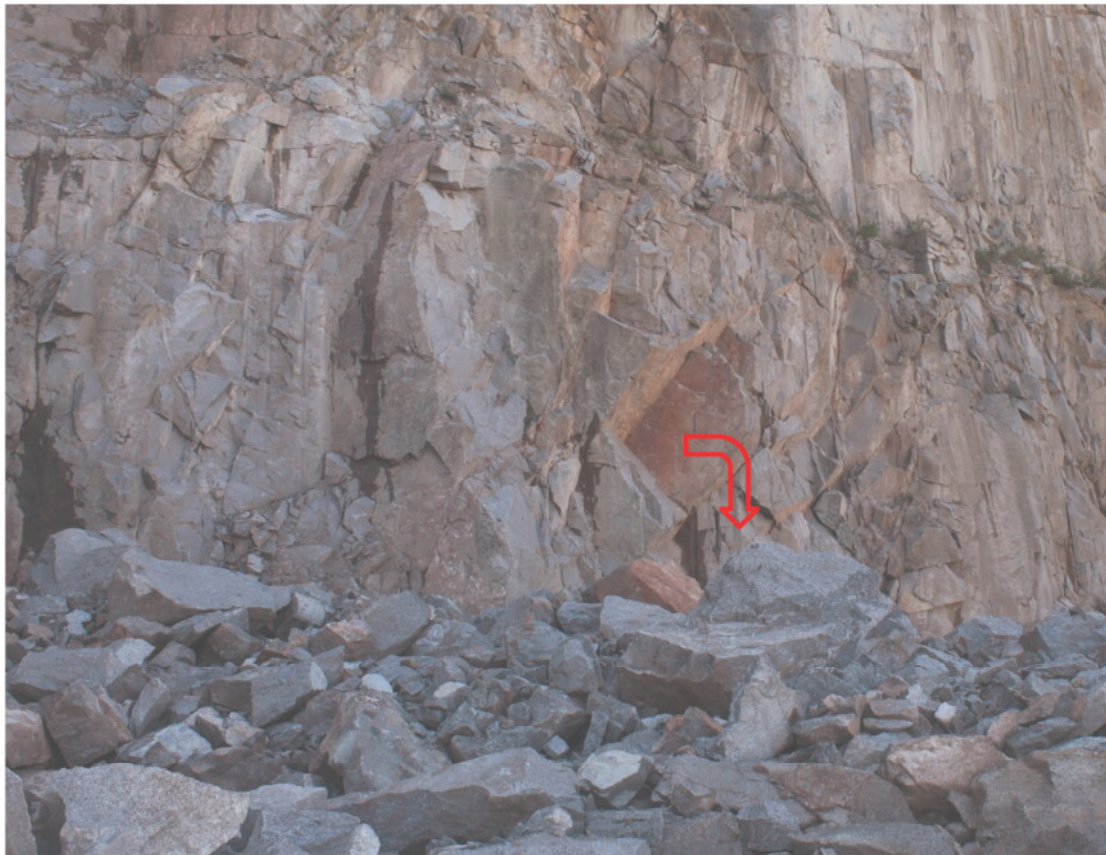
Bild 5.6: aus der Südostwand herausgebrochener Kluftkörper
