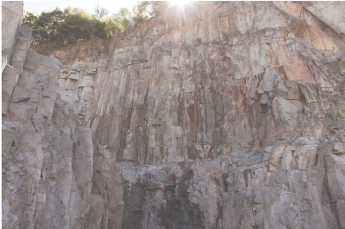
Bild 4.13: Vertikale Erkaltungsrisse in der Südostecke des Steinbruchs
