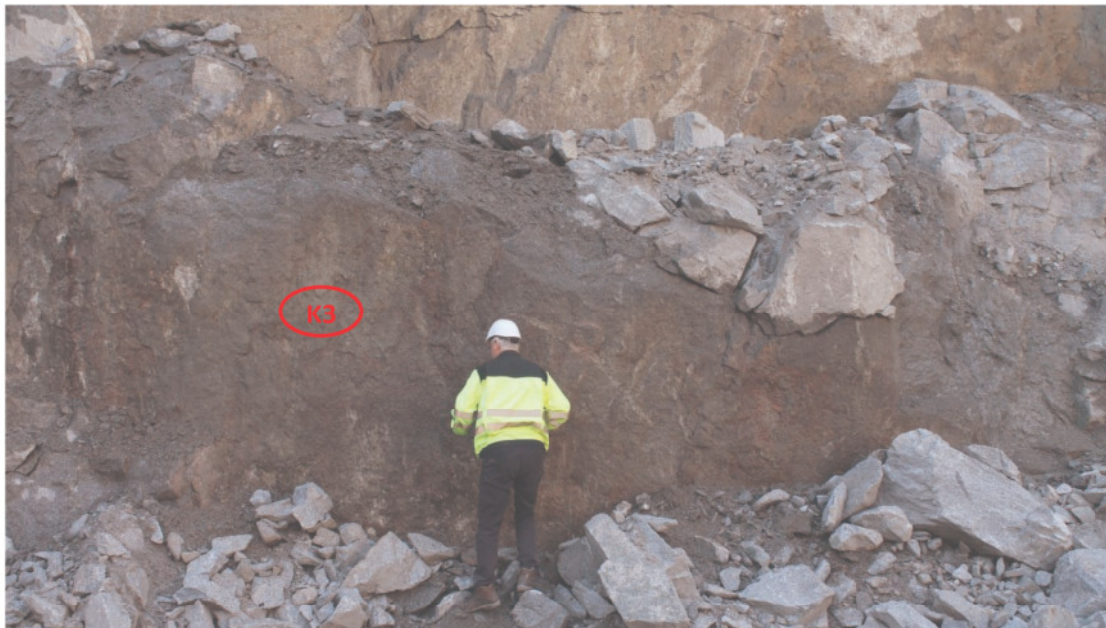
Bild 4.9: Kluftschar K3 auf der Südseite
