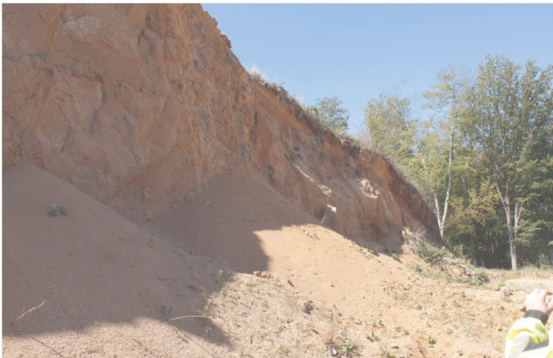
Bild 4.15: Sandkegel bzw. -fächer vor der Wand aus verwitterten Gesteinen in der Südwestecke
