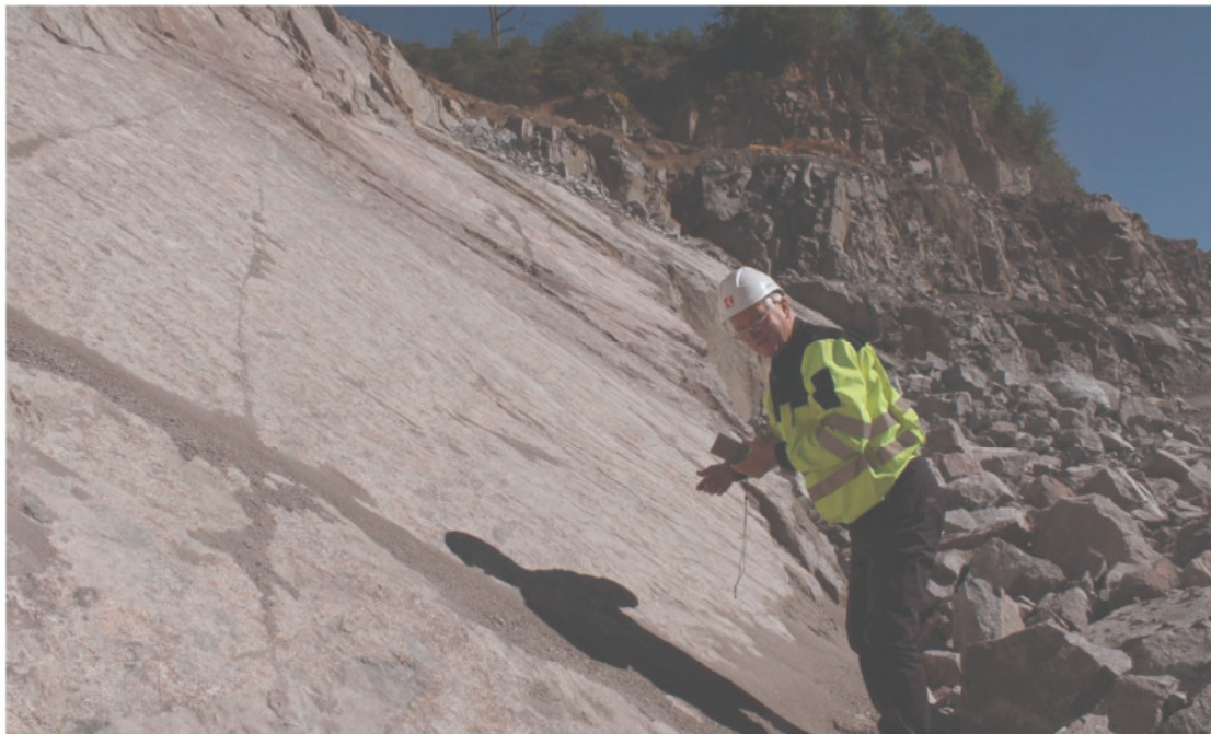
Bild 4.3: nach SE einfallende ebene Trennflächen der Schar K1 auf der NW-Seite
