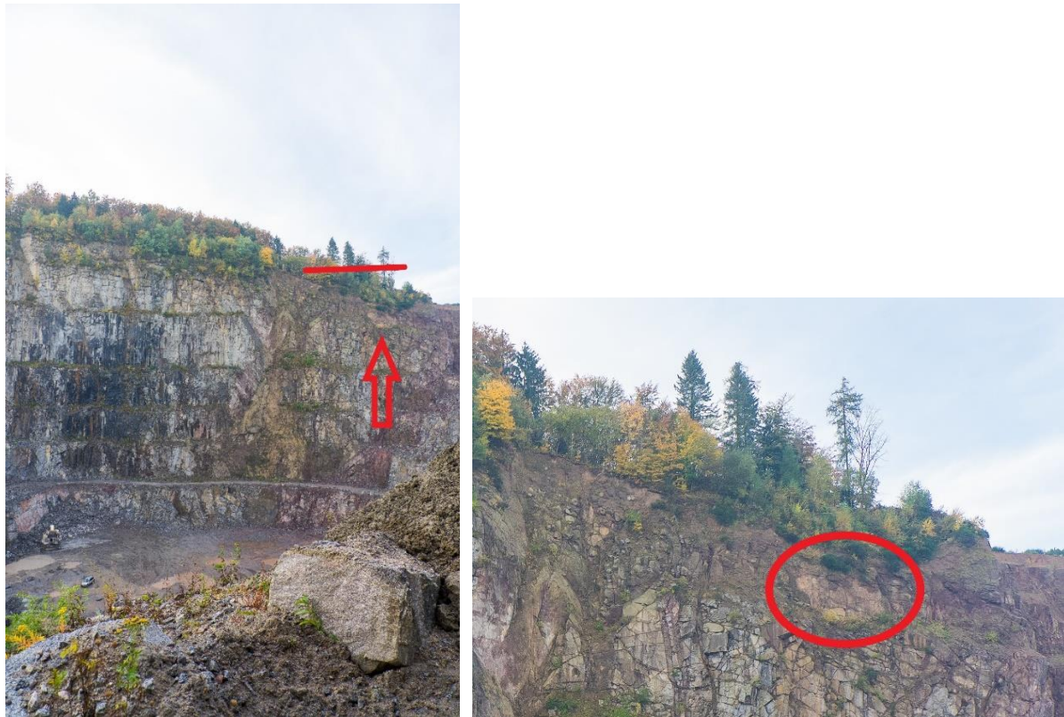
Abbildung 10: Bild links: Position 4 geplante Lage in der Südwand; Bild rechts: Standort-detail
