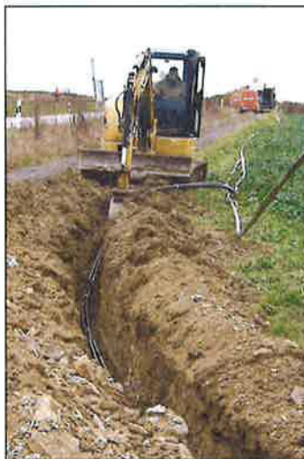
Abbildung 3: offene Bauweise mit Kleinbagger (Foto: gutschker-dongus)
