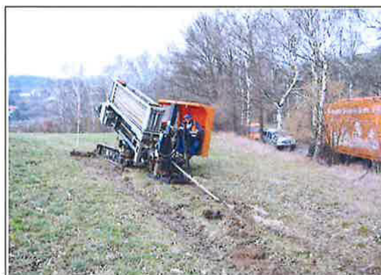
Abbildung 4: Bohrmaschine im Einsatz (Foto: gutschker-dongus)
