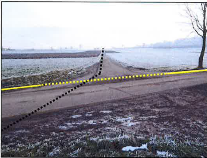
Abbildung 12: Querungsbereich der geplanten Kabeltrasse (schwarz) mit einem straßenbegleitenden Entwässerungsgraben (gelb); Blickrichtung: Süden (Foto: T. Harnack)
