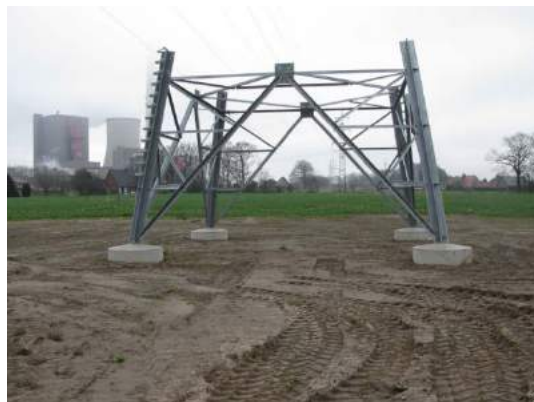
Abbildung 5: Plattenfundament vor und nach der Verfüllung der Baugrube
