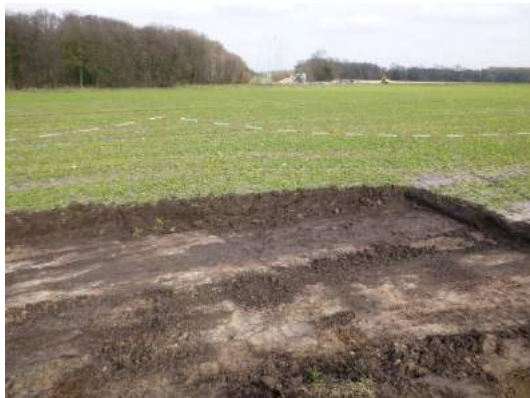
Abbildung 2: Abtrag des Oberbodens im Bereich eines Neubaumastes
