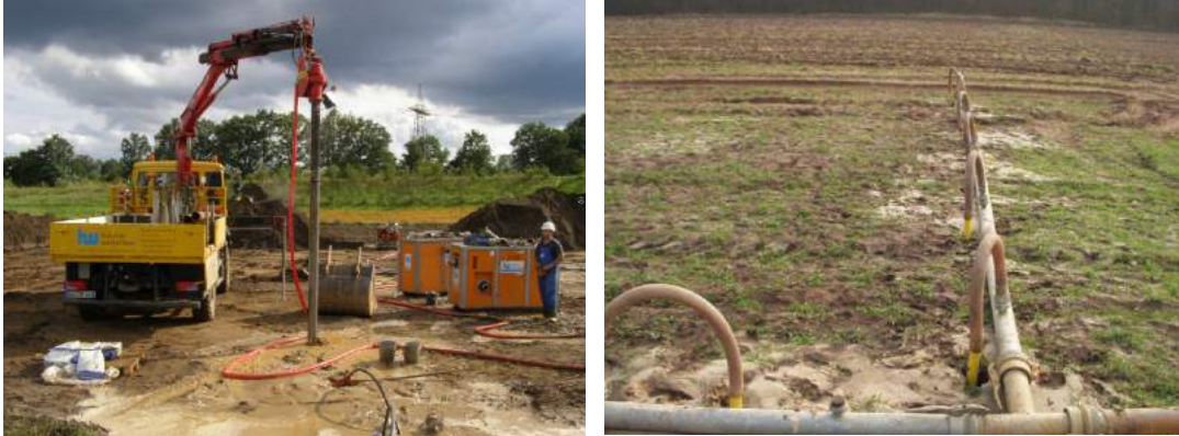
Abbildung 3: Einrichtung der Wasserhaltung mittels Spüllanzen*
