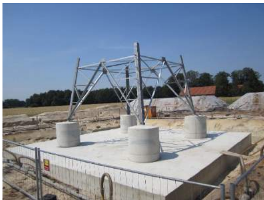
Abbildung 5: Plattenfundament vor und nach der Verfüllung der Baugrube
