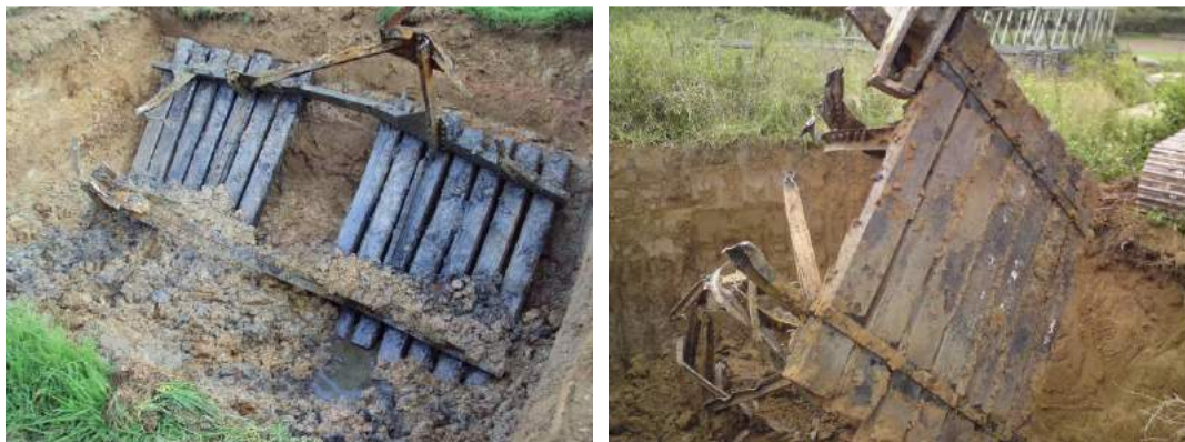
Abbildung 7: Freilegung der Schwellenfundamente
