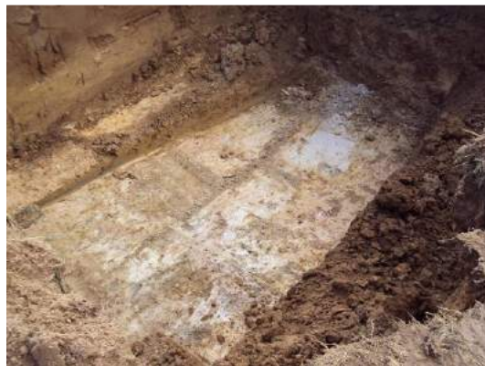
Baugrubensohle nach Aushub des belasteten Bodens
