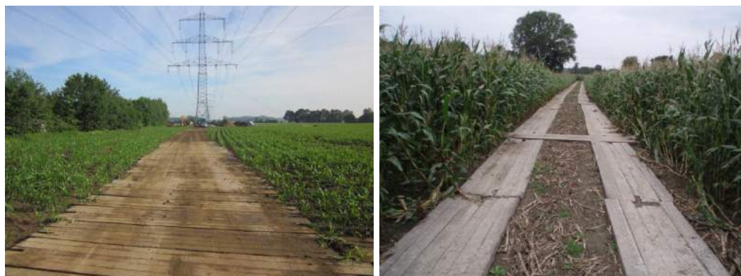
Abbildung 1: Baustraße als temporäre Zuwegung zum Maststandort
