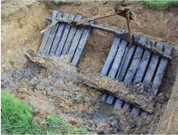
Abbildung 6: Freilegung der Schwellenfundamente
