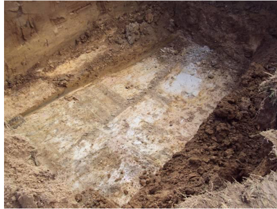
Baugrubensohle nach Aushub des belasteten Bodens
