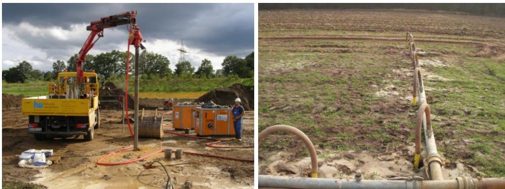
Abbildung 3: Einrichtung der Wasserhaltung mittels Spüllanzen
