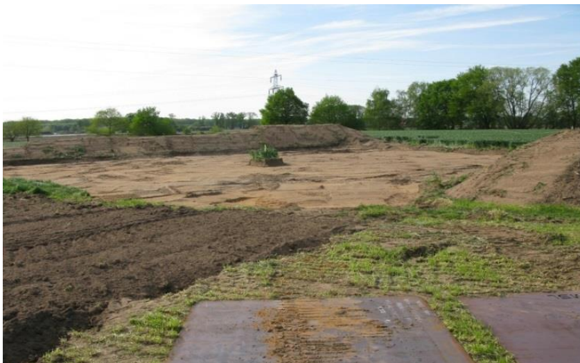
Abbildung 2: Abtrag und Zwischenlagerung des Oberbodens
