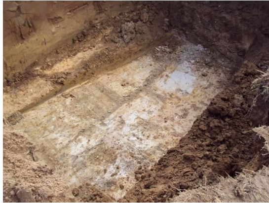
Baugrubensohle nach Aushub des belasteten Bodens
