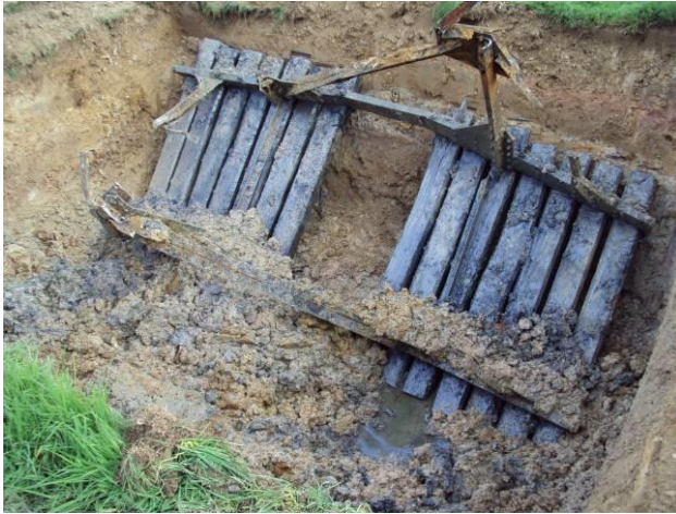
Abbildung 6: Freilegung der Schwellenfundamente
