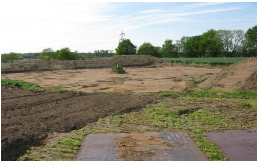
Abbildung 2: Abtrag und Zwischenlagerung des Oberbodens
