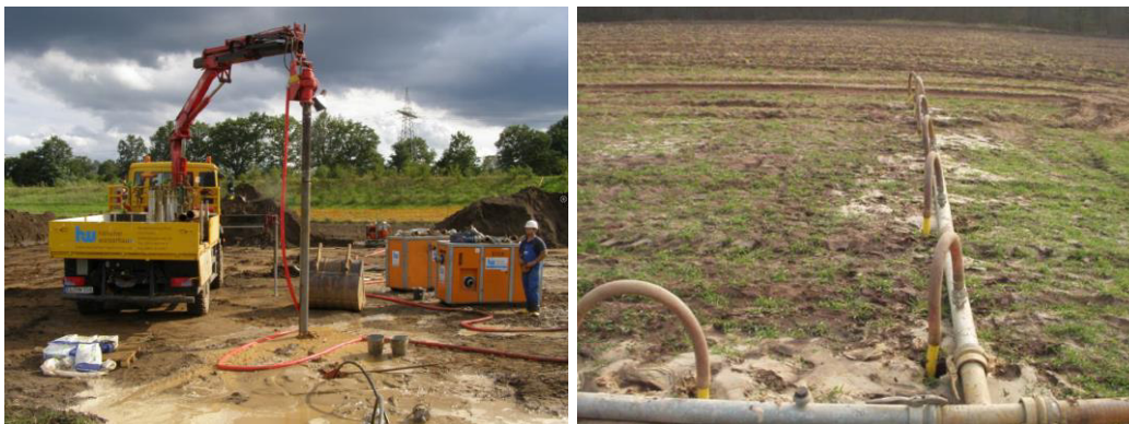
Abbildung 3: Einrichtung der Wasserhaltung mittels Spüllanzen
