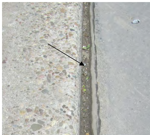
MP5, Fugenfüllmaterial / Rinnenlängsfugen (schwarz)
