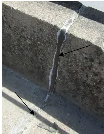
MP4, Fugenfüllmaterial / Kappen- Höckerquerfugen (grau)
