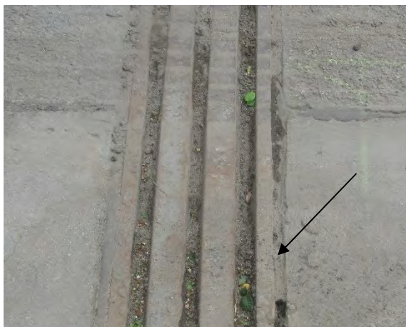
MP8, Fugenfüllmaterial / Quertugen ÜKO (schwarz)
