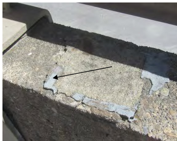
MP6, Fugenfüllmaterial / Instandsetzungsstellen Betonhöcker (grau)
