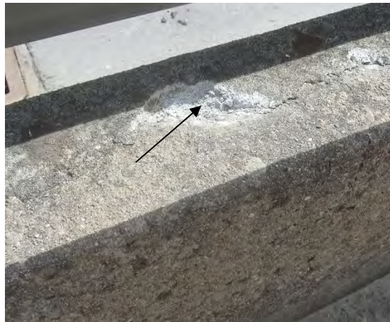
MP7, Beschichtung / Betonhöcker
