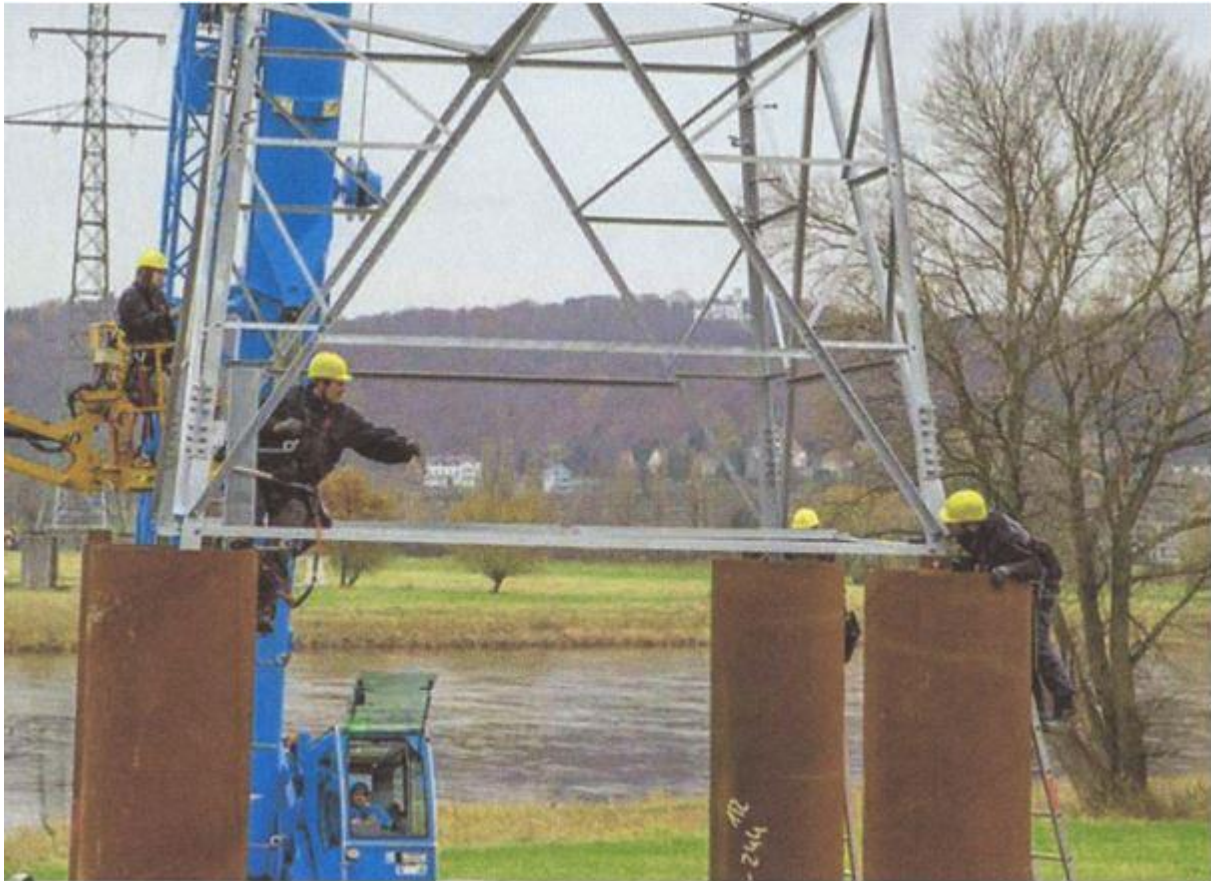
Abbildung 5: Foto von der Herstellung eines Hochwasserfundamentes
