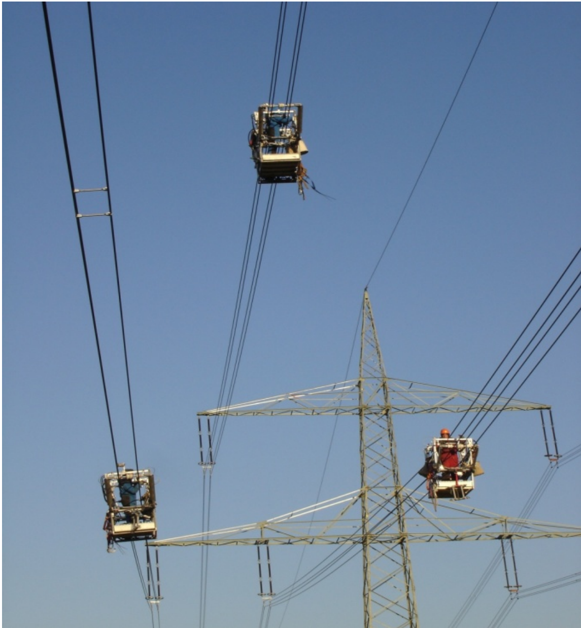
Abbildung 23: Montage der Feldbündelabstandhalter mit Fahrwagen
