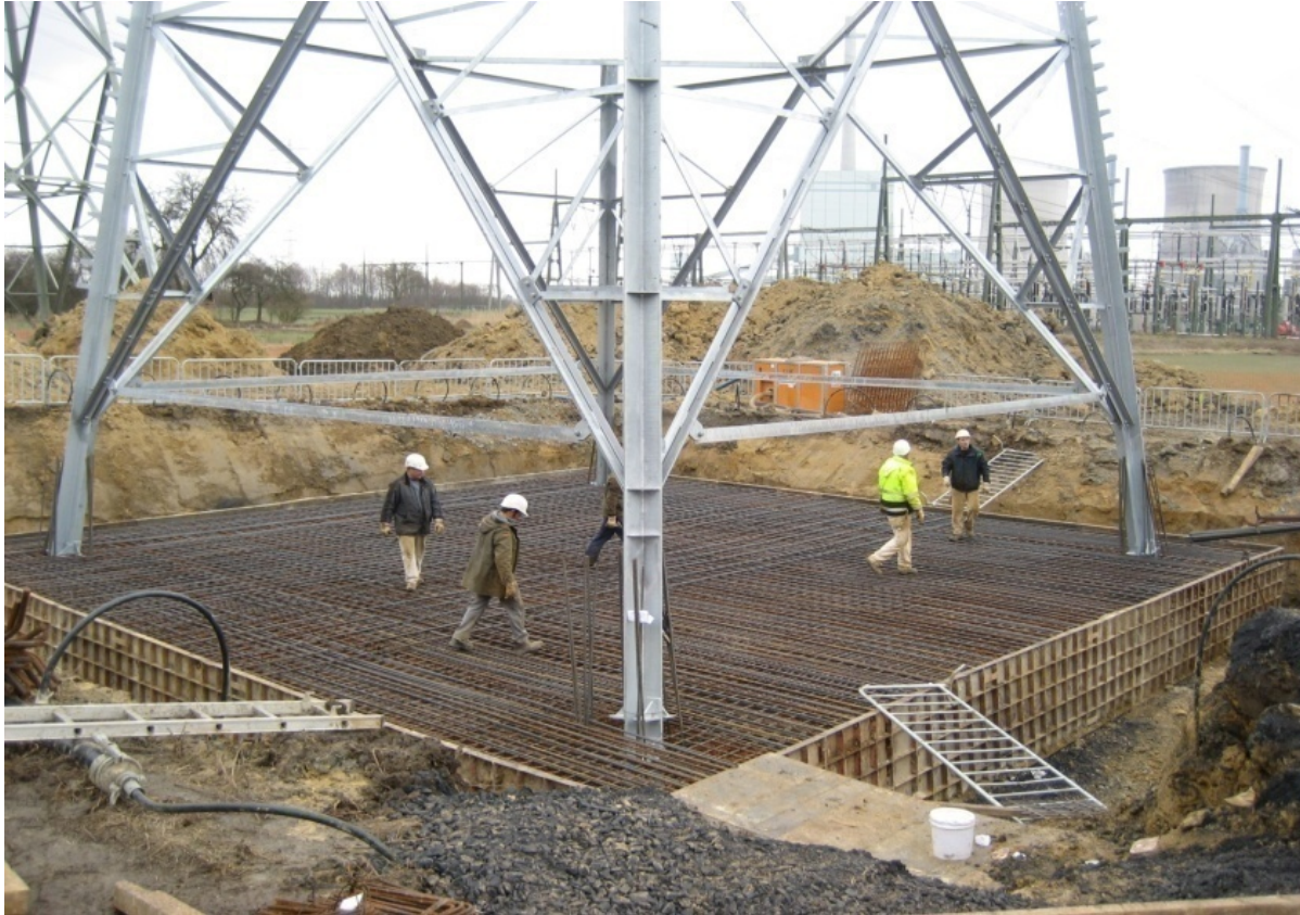
Abbildung 17: Montage der Fundamentbewehrung
