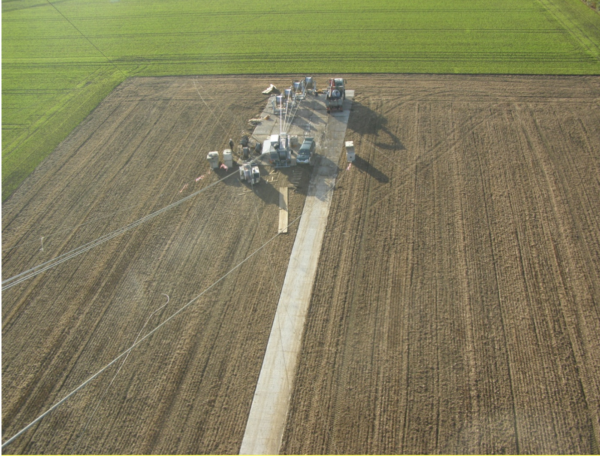
Abbildung 22: Windenplatz eines 4er-Bündel-Seilzuges
