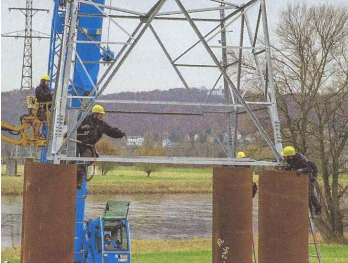
Abbildung 11: Herstellung eines Hochwasserfundaments
