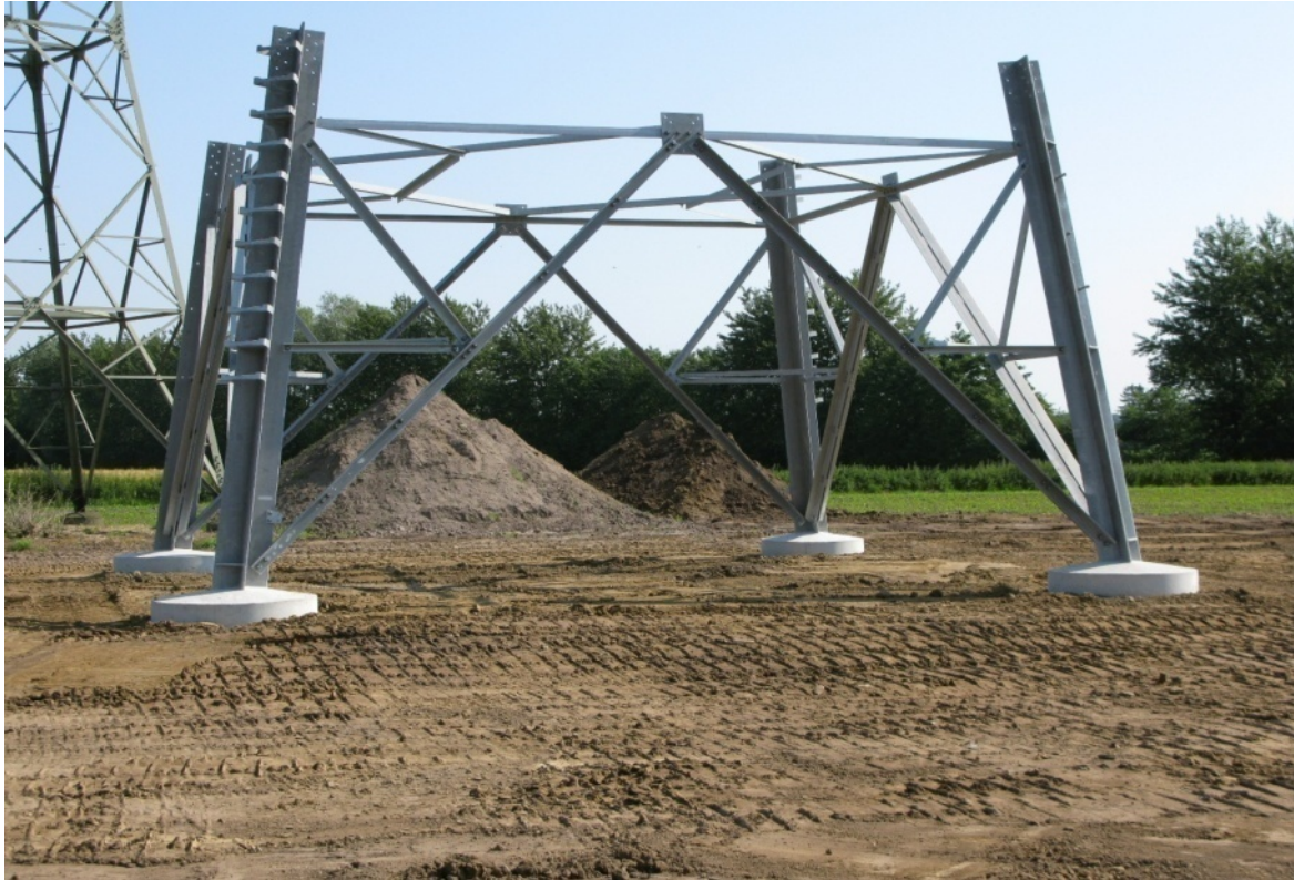
Abbildung 18: Montierter Mastfuß
