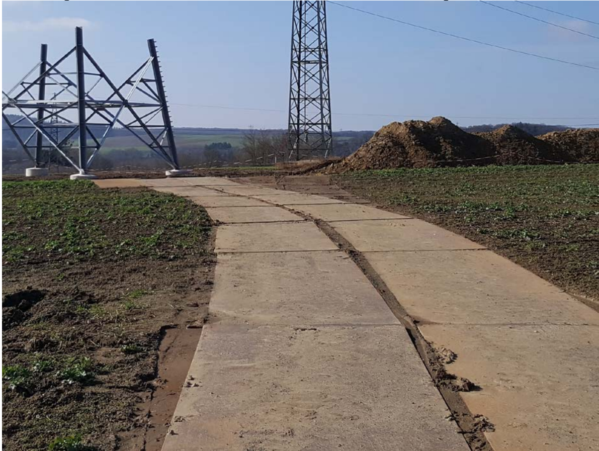
Abbildung 12: Temporäre Zuwegung über Fahrplatten
