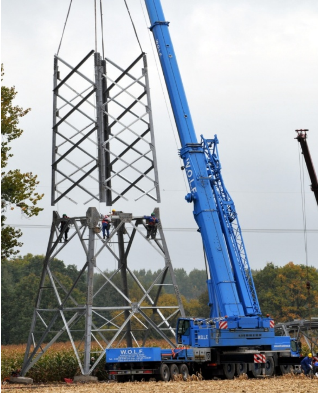
Abbildung 19: Mastmontage (Stocken)
