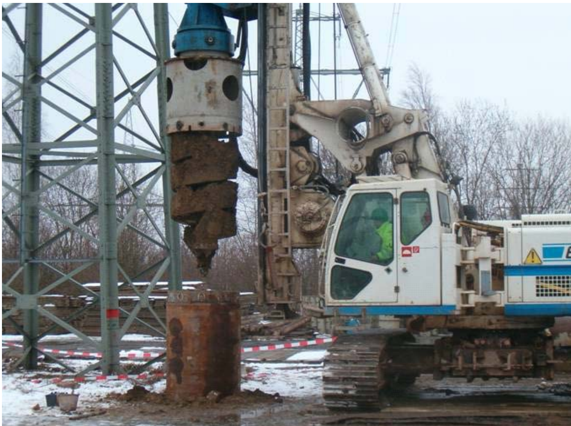
Abbildung 16: Bohrung für einen Bohrpfahl
