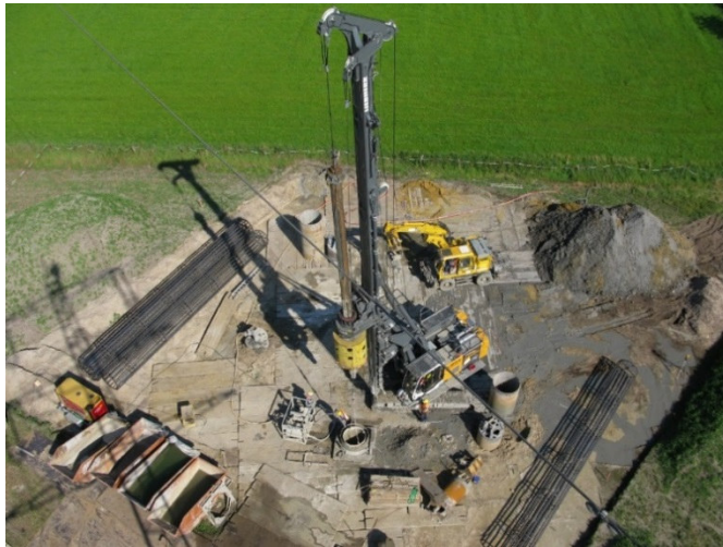
Abbildung 8: Erstellung der Bohrpfähle
