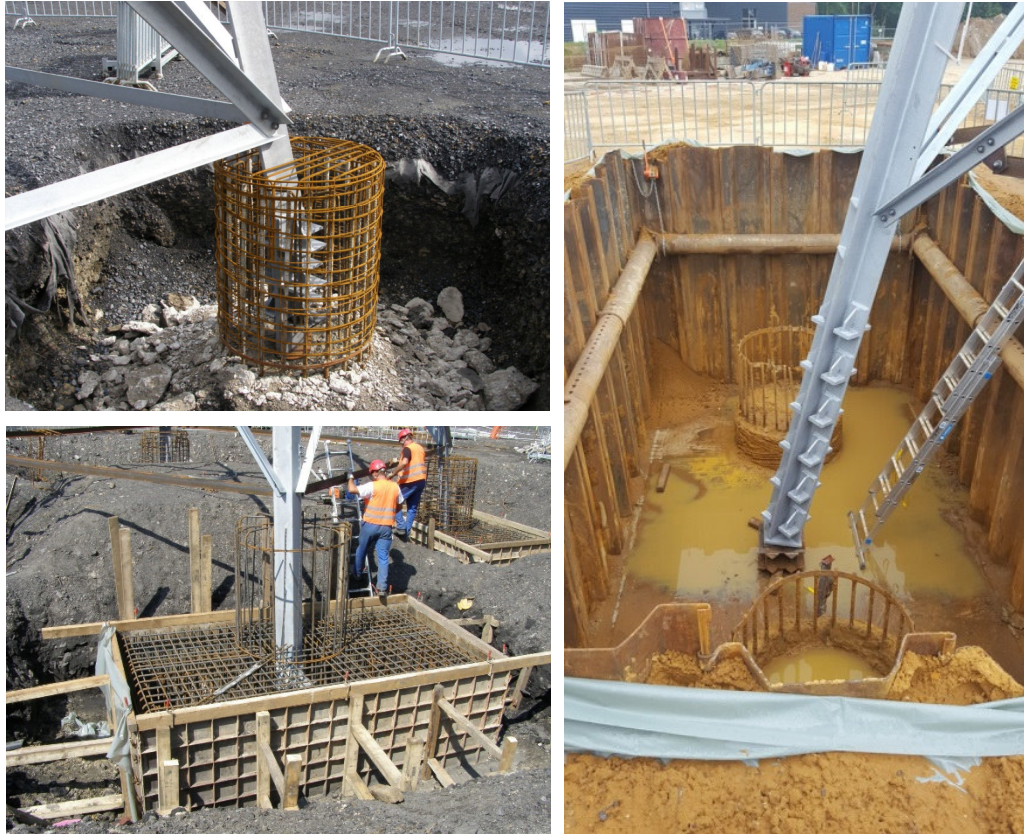
Abbildung 11: Anbindung der Eckpfähle nach dem Betonieren
