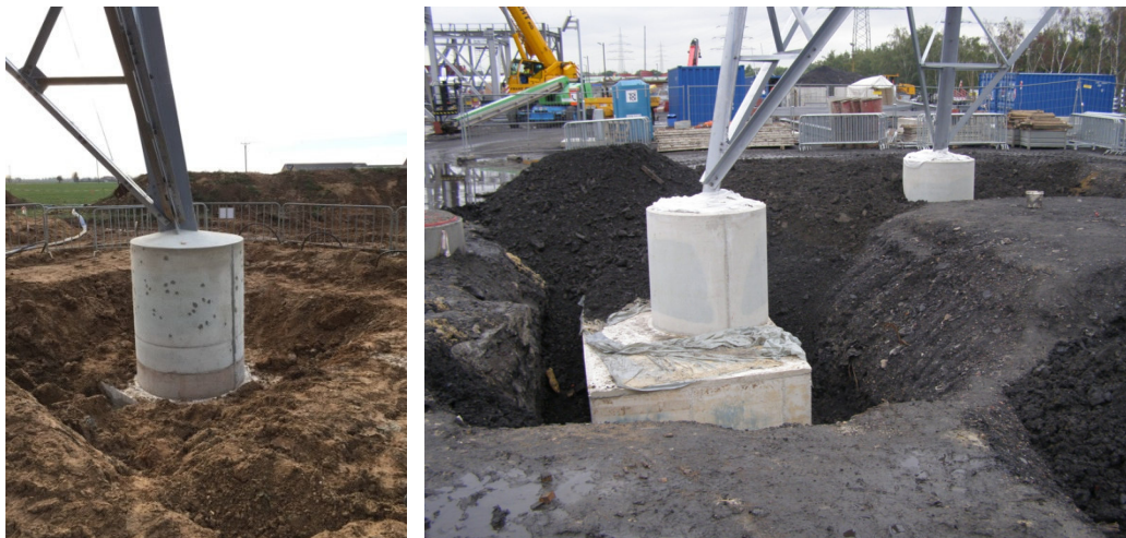
Abbildung 11: Anbindung der Eckpfähle nach dem Betonieren
