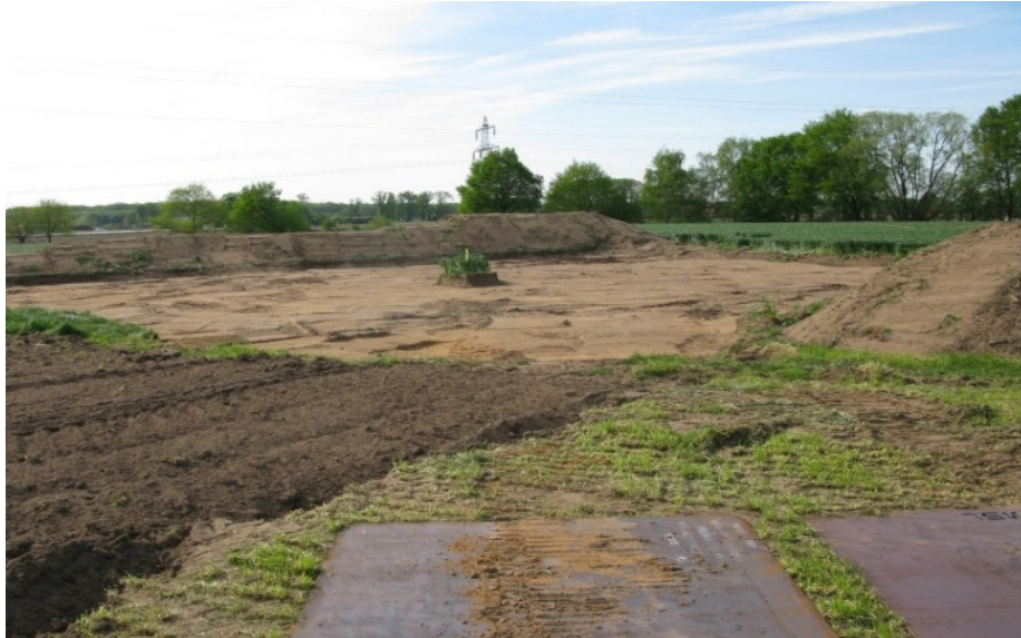
Abbildung 3: Abtrag des Oberbodens im Bereich eines Neubaumastes
