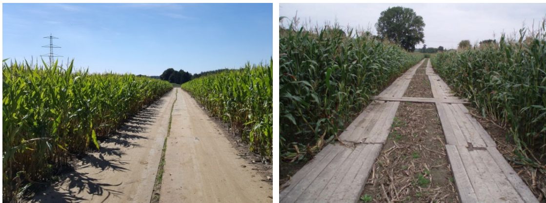
Abbildung 2: Baustraße als temporäre Zuwegung zum Maststandort
