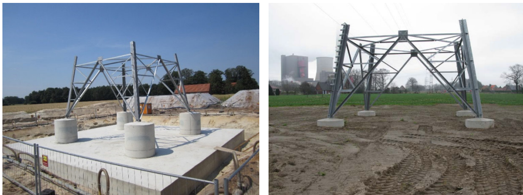
Abbildung 6: Plattenfundament vor und nach der Verfüllung der Baugrube
