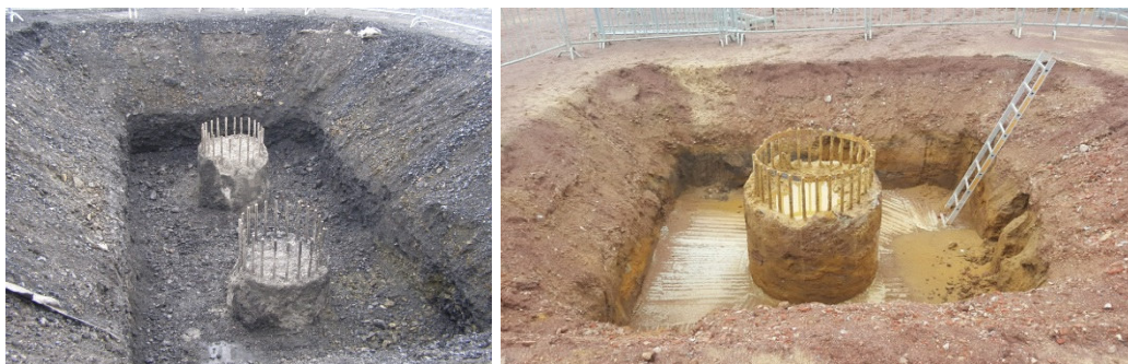
Abbildung 9: Freilegen der Bohrpfähle
