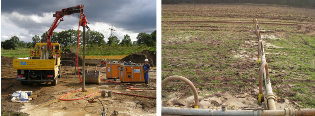
Abbildung 4: Einrichtung der Wasserhaltung mittels Spüllanzen
