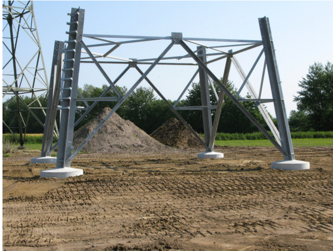
Abbildung 12: Mastfuß nach Errichtung und Anbindung an die Bohrpfähle
