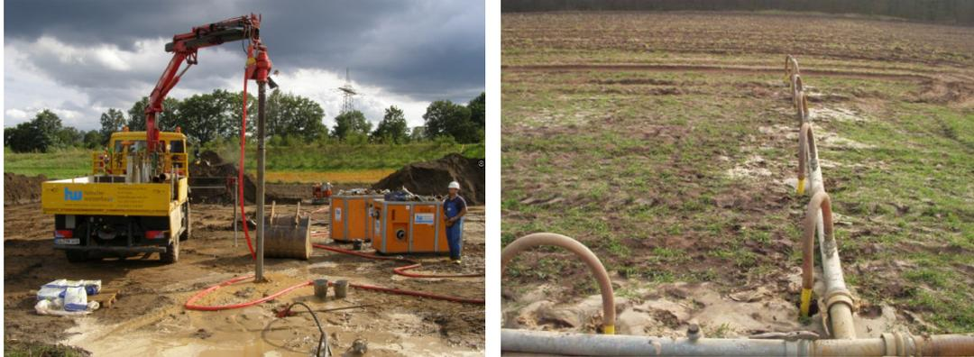
Da der Grundwasserstand stark vom Zeitpunkt der Bauausführung abhängig ist, kann es vorkommen, dass auch an Maststandorten mit zeitweilig hohen Grundwasserständen in niederschlagsschwachen Zeiten keine Grundwasserabsenkung erforderlich ist.
