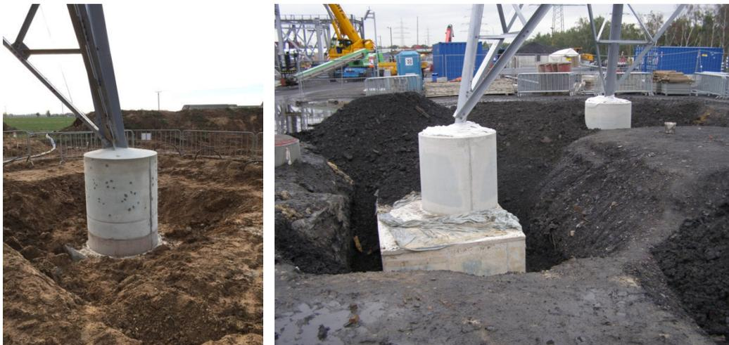
Unmittelbar nach der Erstellung der Fundamentköpfe wird die Baugrube entsprechend der vorgefundenen Bodenschichten wieder verfüllt – die Bauart (Plattenfundament oder Pfahlgründung) ist oberflächennah nicht zu unterscheiden. Nach Abschluss der Verfüllung der Baugrube sind sämtliche Tiefbauarbeiten für die Errichtung des neuen Freileitungsmastes abgeschlossen (siehe Abbildung 12).
