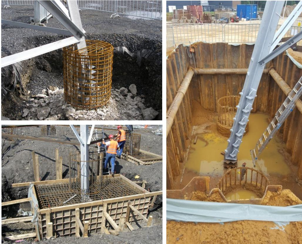
**Abbildung 11: Anbindung der Eckpfähle nach dem Betonieren**
